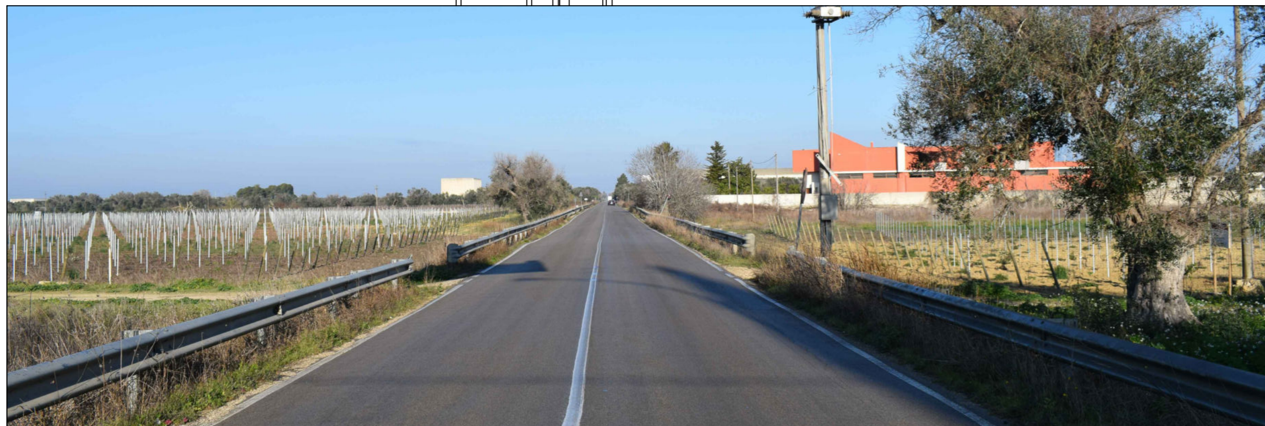
POST OPERAM - E' visibile in primo piano l'aerogeneratore M05, verso nord è visibile aerogeneratore M07, in direzione sud sono visibili gli aerogeneratori M01 ed M03. Gli aerogeneratori si inseriscono in un paesaggio pianeggiante privo di elementi con valenza paesaggistica e pertanto non interferiscono, ma interagiscono con il paesaggio.
