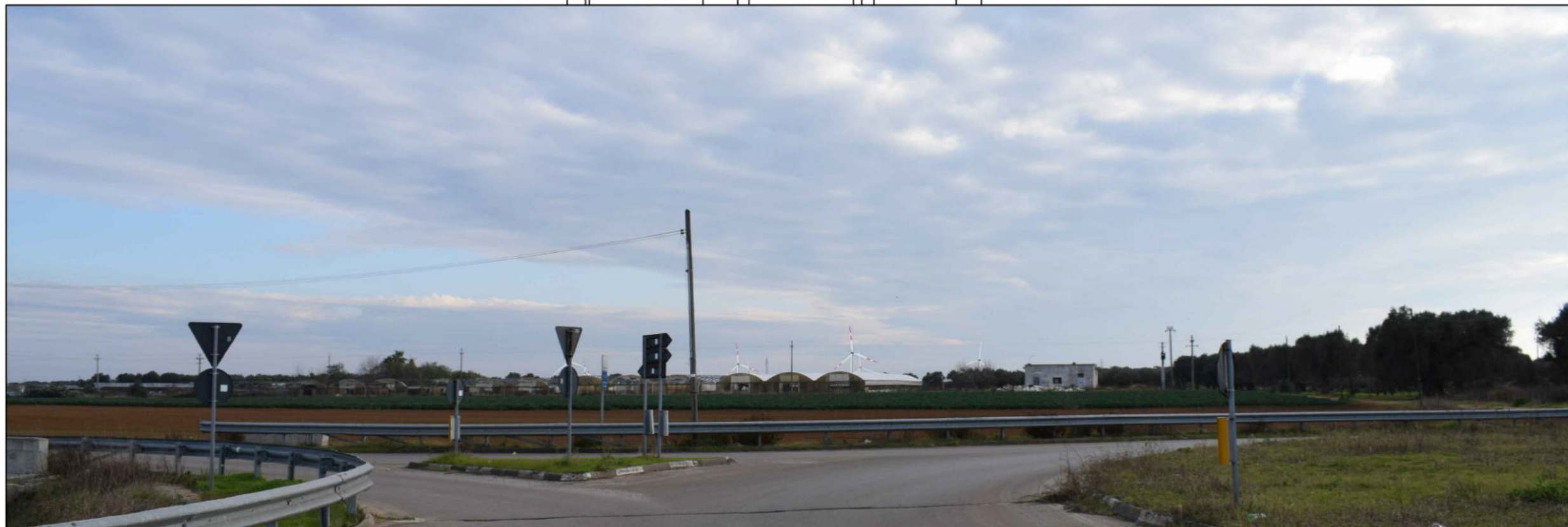
POST OPERAM - Sono visibili da nord verso sud seguenti aerogeneratori M09, M10, M01, M11, M07, M03, M05, questi si inseriscono in un paesaggio pianeggiante privo di elementi con valenza paesaggistica e pertanto non interferiscono, ma interagiscono con il paesaggio.
