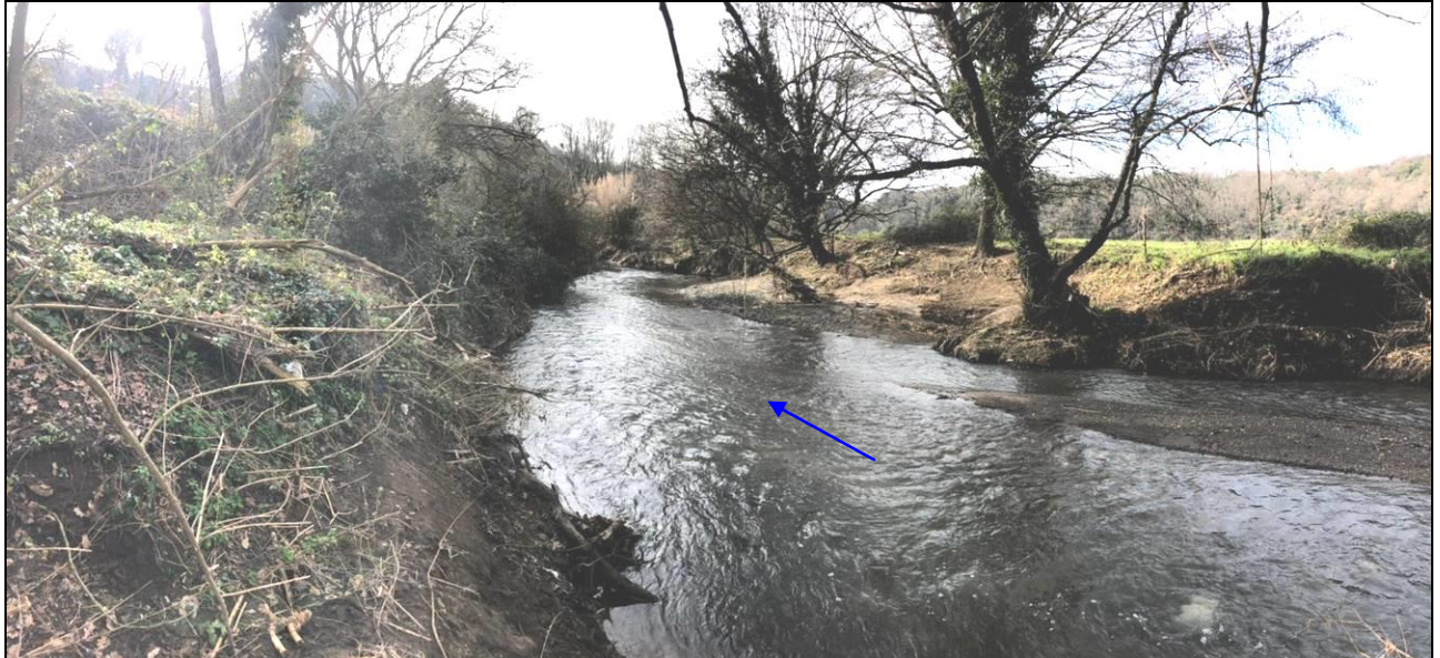
Foto 3.1/A – Tratto di alveo in corrispondenza dell'attraversamento
