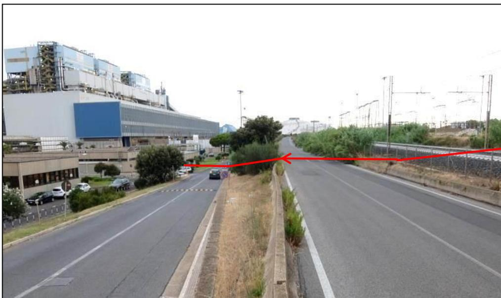
**Foto 3.2/C – Discesa del tracciato lungo la scarpata, con attraversamento della linea ferroviaria, della strada della Torre Valdaliga e della strada Enel (linea rossa metanodotto in progetto)**
