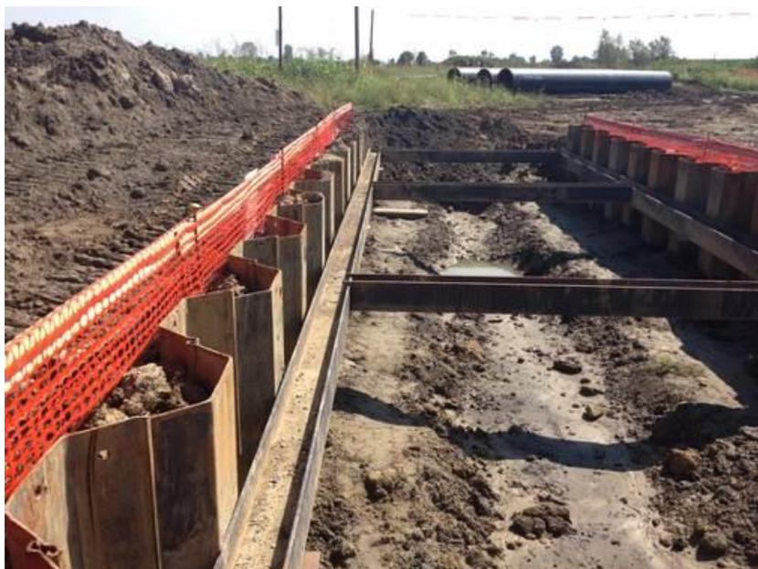
**Foto 2.9/A – Scavo e palancole per attraversamento con spingitubo**
