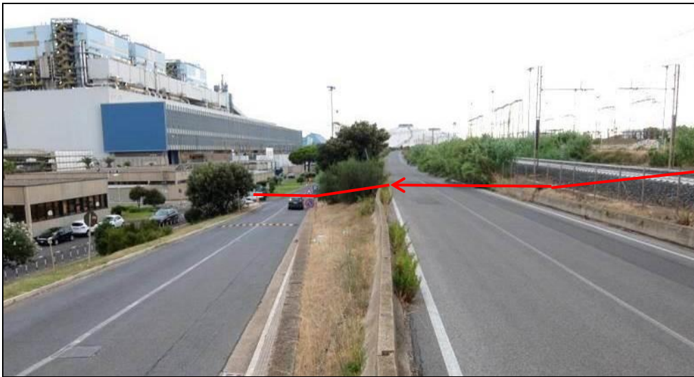
Foto 3.2/A – Discesa del tracciato lungo la scarpata, con attraversamento della linea ferroviaria, della strada della Torre Valdaliga e della strada Enel (tracciato di progetto linea rossa)
