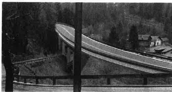
Compluvio tra via Senes e il rilevato nord del viadotto
