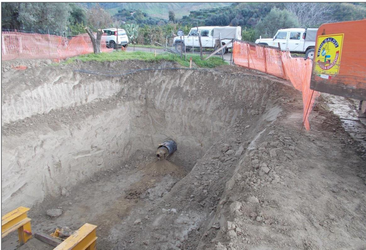
**Foto 3.4/G Trivellazione con spingitubo**
