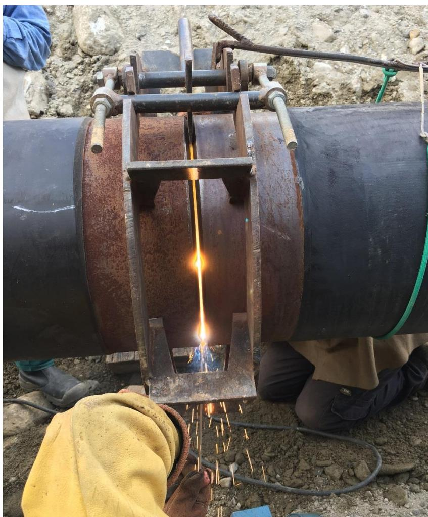
**Foto 3.4/D: Saldatura**
