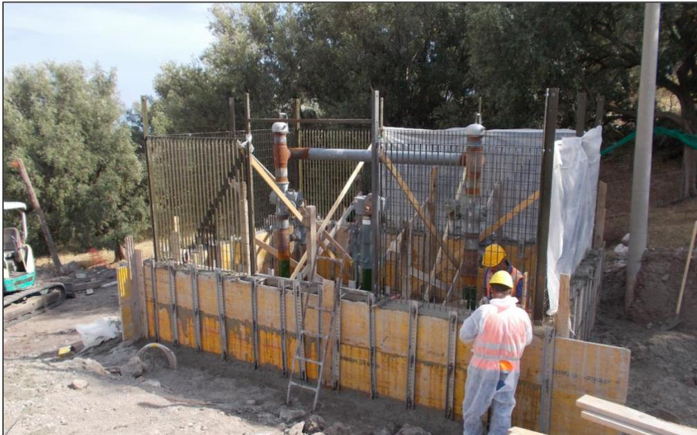
**Foto 3.4/I: Costruzione di un punto di intercettazione di derivazione importante (P.I.D.I.)**
