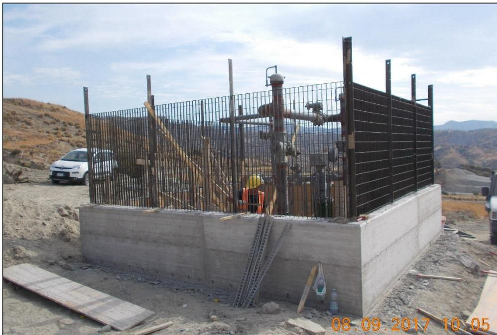
**Foto 3.4/L: Costruzione di un punto di intercettazione di derivazione importante (P.I.D.I.)**
