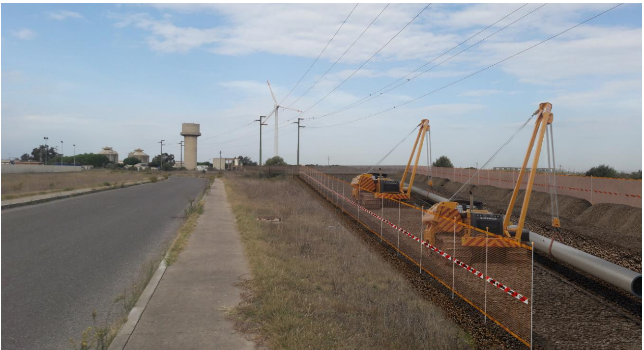
Fig. 3/L - Posa della condotta nella trincea di scavo
