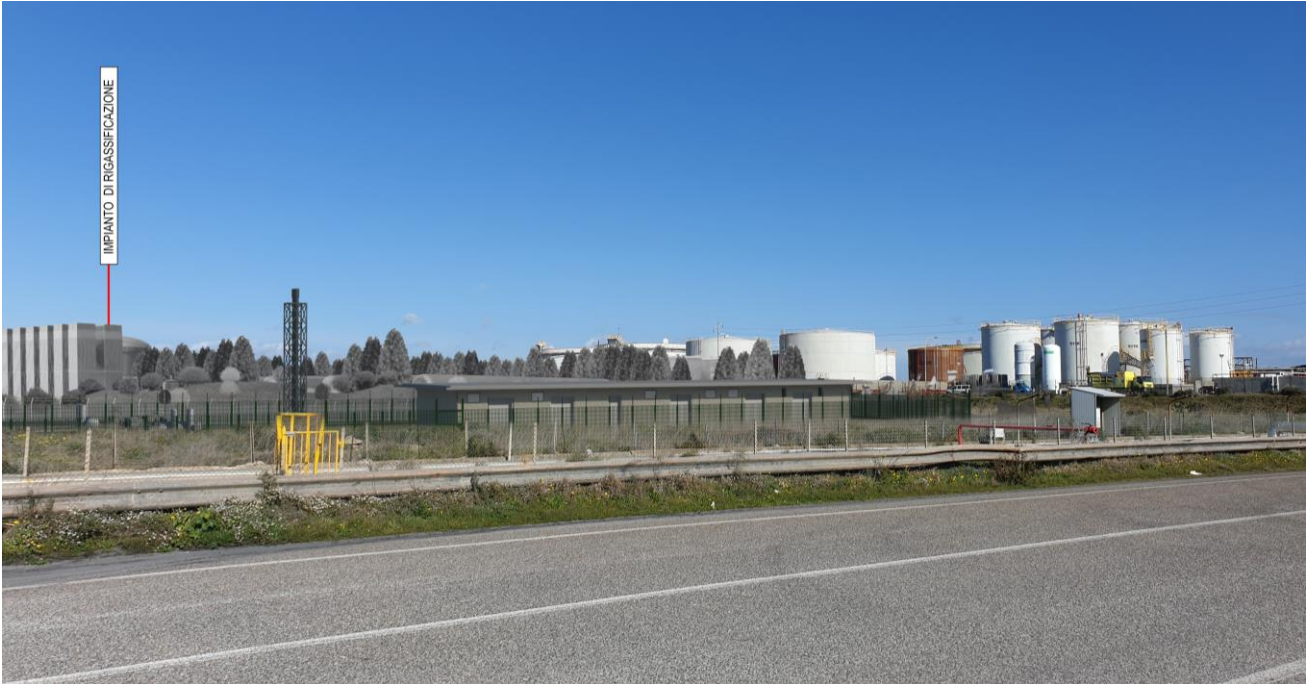
Fig. 3/O – Realizzazione del nuovo impianto P.D.E. n.1 ubicato all'interno dell'impianto di Stoccaggio, Rigassificazione e Distribuzione GNL nel Porto di Oristano – Santa Giusta di IVI Petrolifera S.p.A.
