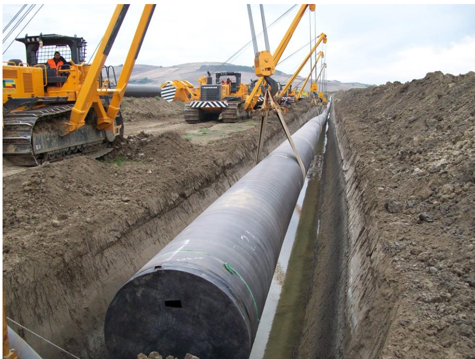
Fig. 9/E: Posa della condotta
