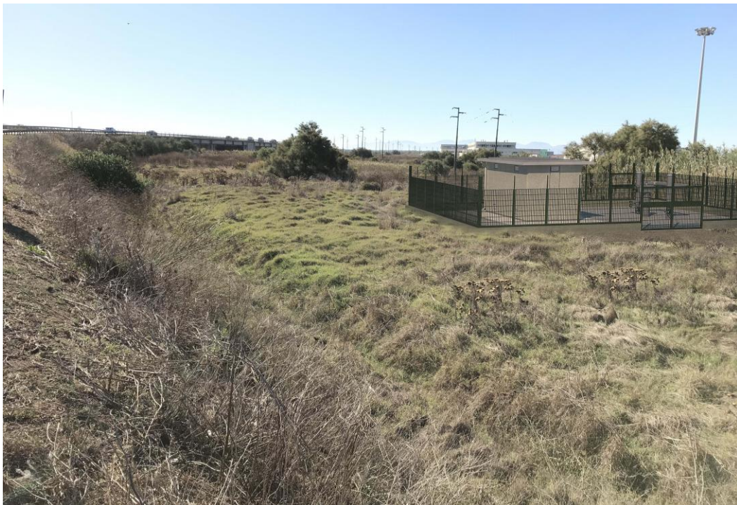
Fig. 3/R – Realizzazione del nuovo impianto di linea PIDI n.2
