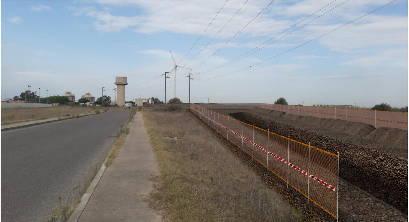
Fig. 3/I - Realizzazione della trincea di scavo
