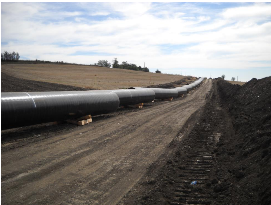
Fig. 9/C: Sfilamento tubazioni
