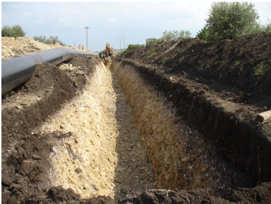
Fig. 9/D: Scavo della trincea
