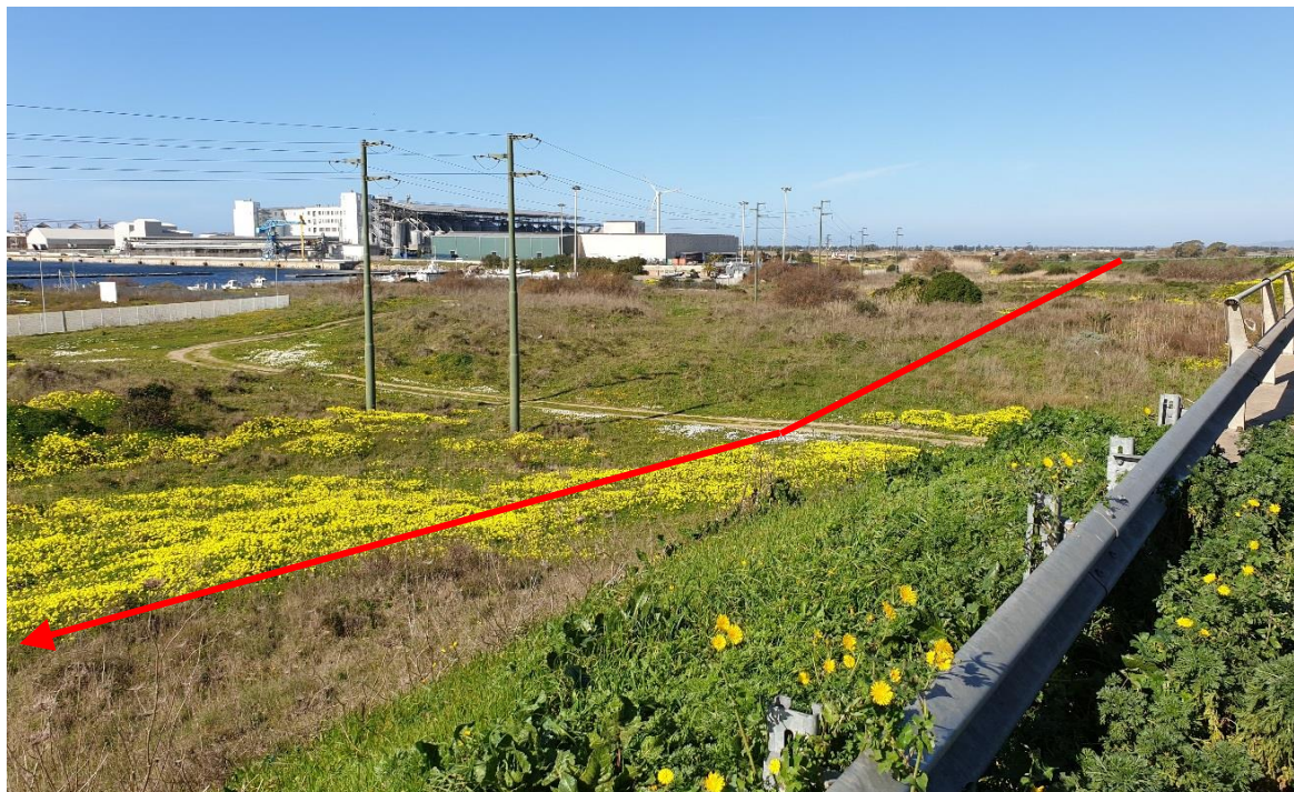
Foto 3/D: Area caratterizzata da vegetazione incolta in corrispondenza dell'uscita della Trivellazione Orizzontale Controllata (T.O.C.)
