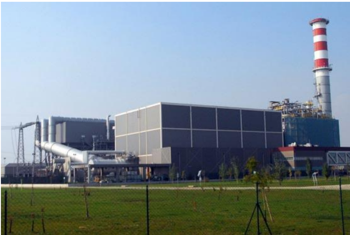
Figura 4-1 Localizzazione della centrale di Voghera
