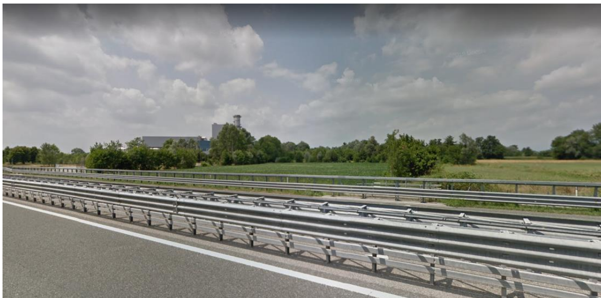
Figura 6-6 "Fattore di compromissione". Visuale dal tratto di autostrada soggetto a vincolo paesaggistico in cui si inserisce la Centrale termoelettrica.
