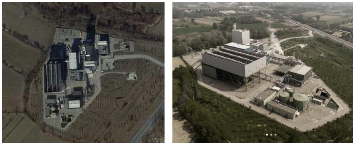
Figura 4-1 Sito della Centrale di Leini'
