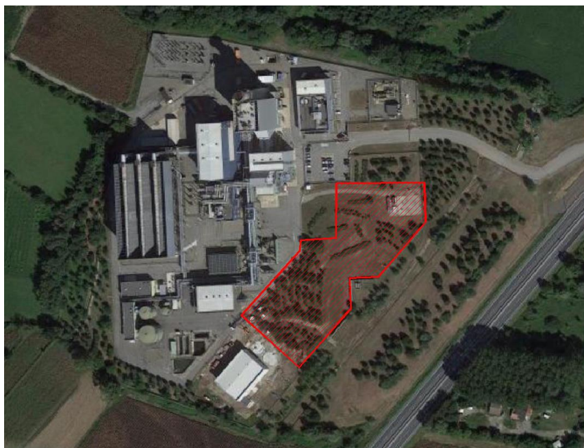
Figura 7-3 Area di cantiere su ortofoto
