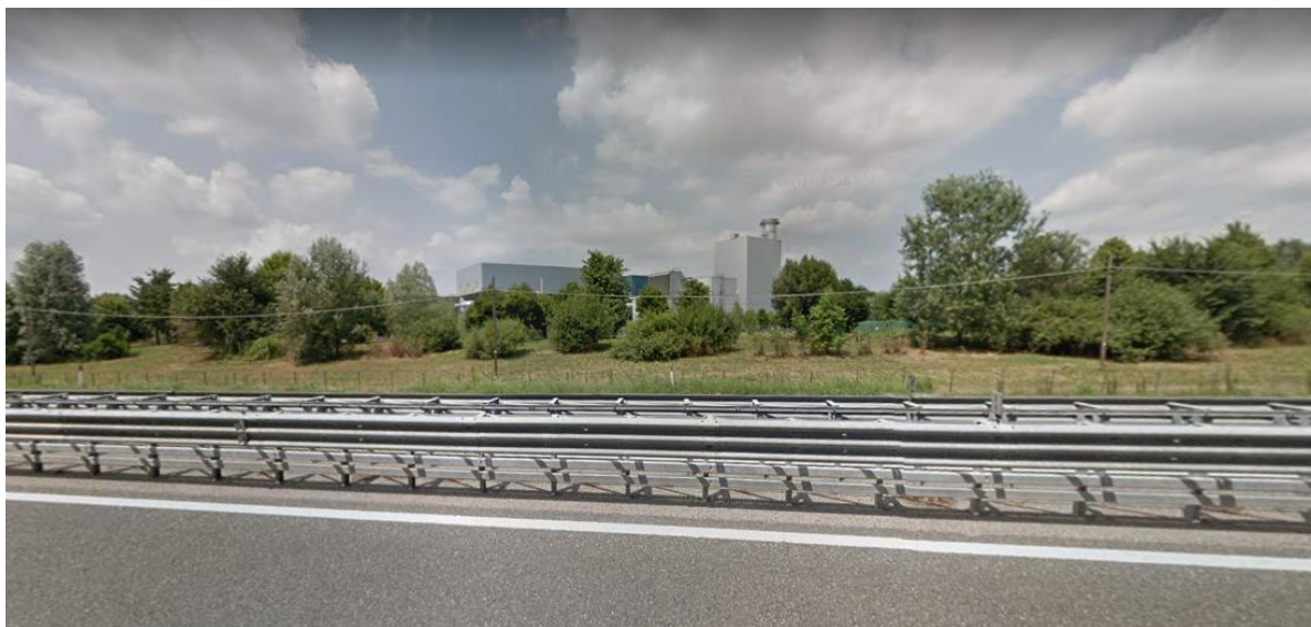
Figura 7-6 Vista frontale dell'area di intervento. Quadro scenico di riferimento.
