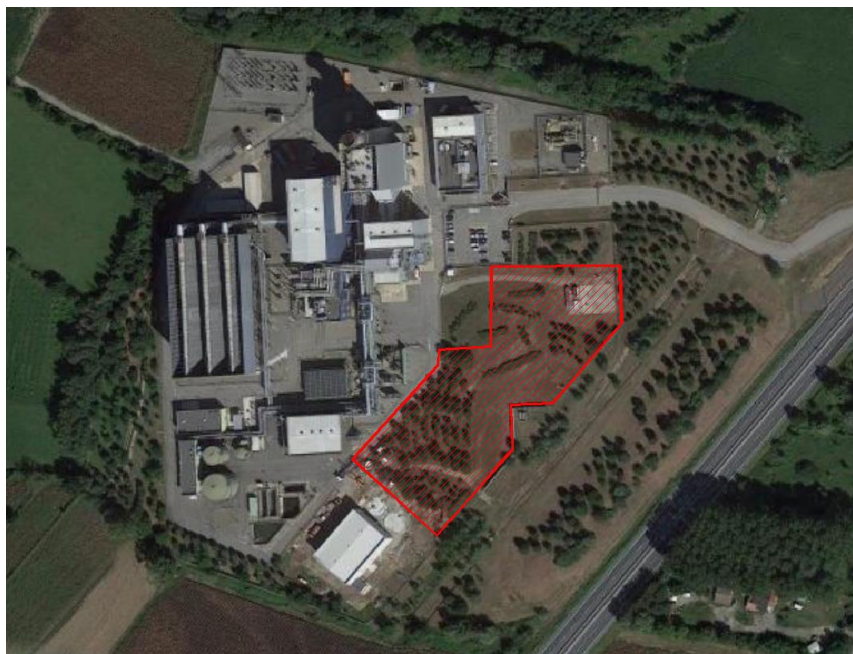
Figura 5-6 Area di cantiere su ortofoto
