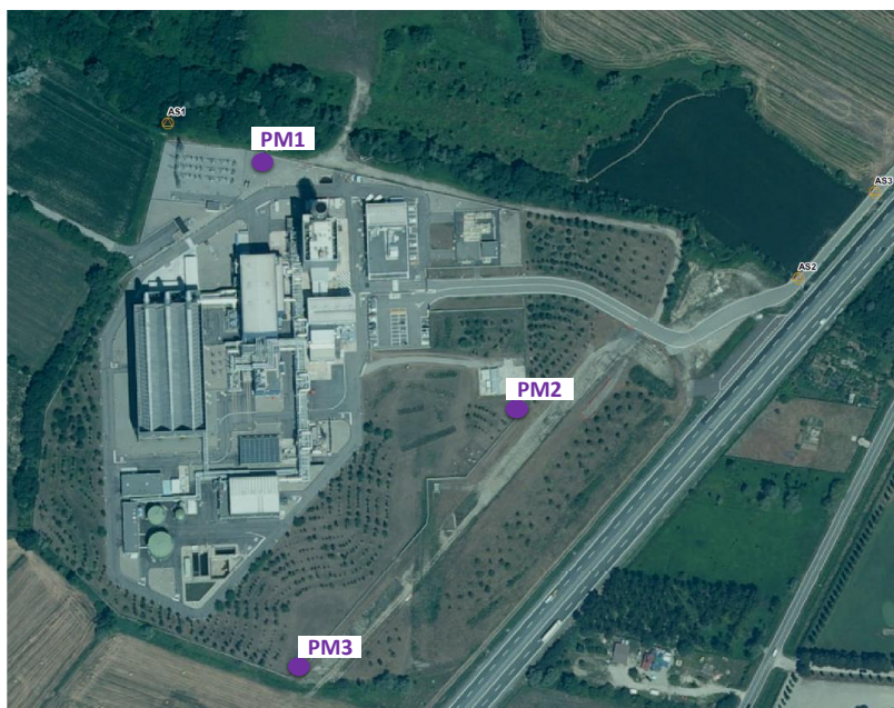
Figura 6-20 Ubicazione punti di monitoraggio acque sotterranee (PM)
