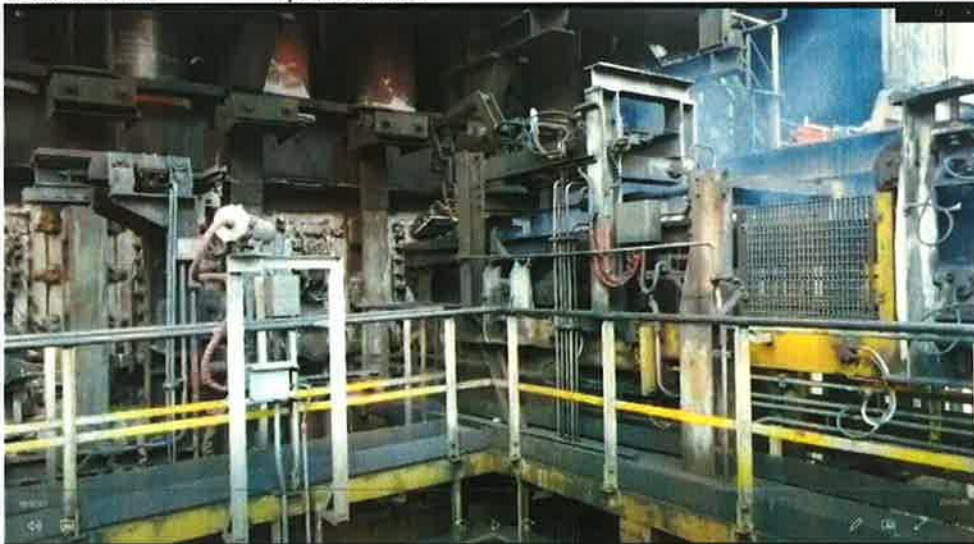
Caricamento - Emissioni al termine della fase di spianamento durante la fuoriuscita dell'asta
