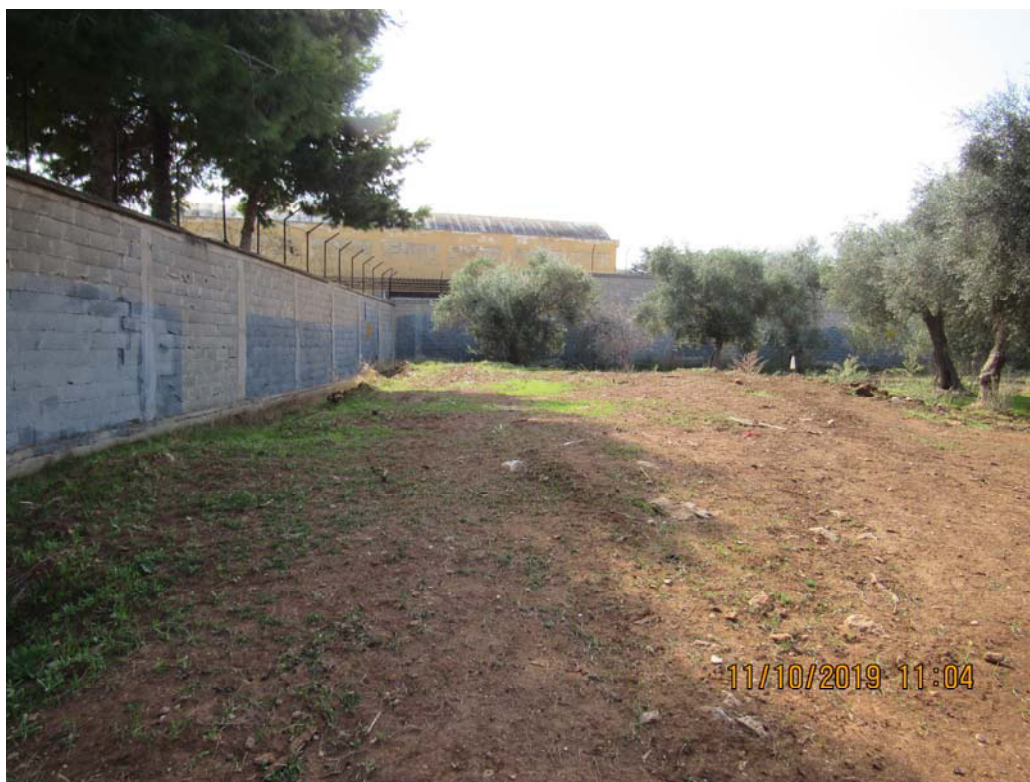
Figura 5-1 Assenza di una copertura erbacea uniforme del Cumulo A
