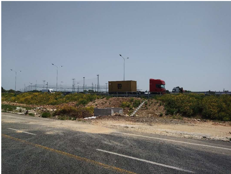
Foto Aree Lavorazioni – Preparazione demolizione rilevato stradale da rifare
