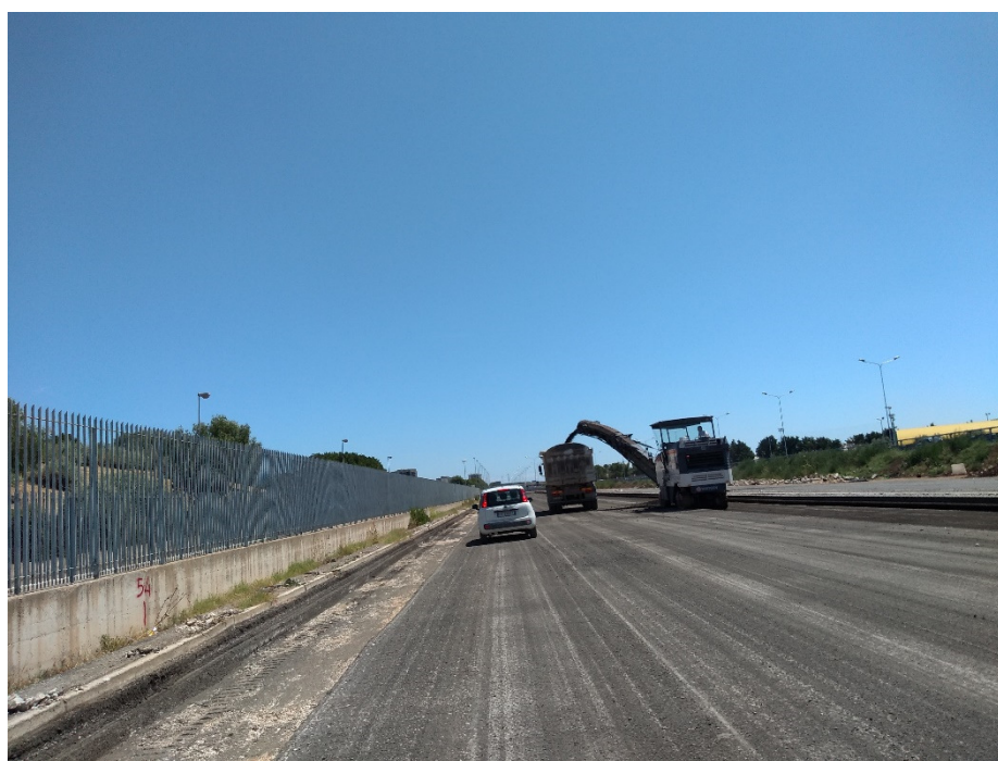
Foto Aree Lavorazioni – Fresatura asfalto esistente
