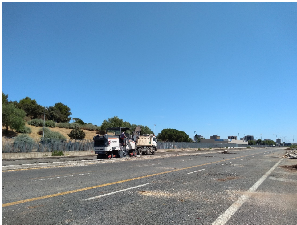
Foto Aree Lavorazioni – Fresatura asfalto esistente
