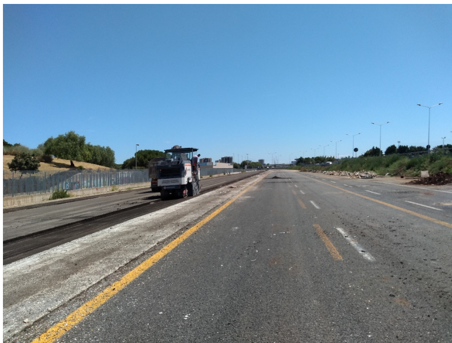
Foto Aree Lavorazioni – Fresatura asfalto esistente
