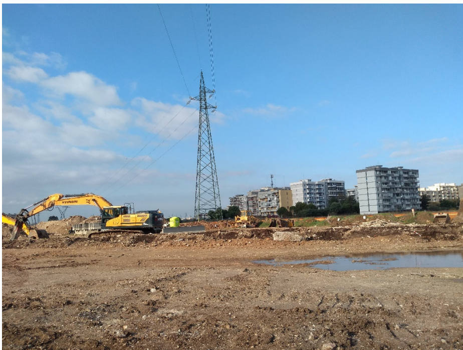
Foto Aree Lavorazioni – Realizzazione corpo rilevato
