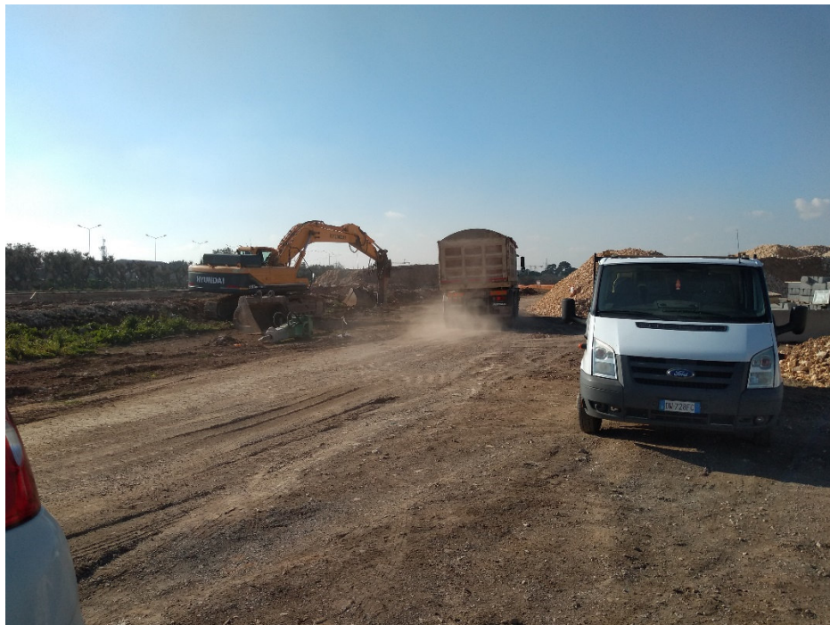
Foto Aree cantiere
