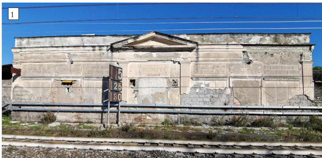
Figura 14: Stato di fatto fabbricati dell'antica Fermata Pompei Scavi – prospetto lato binari
