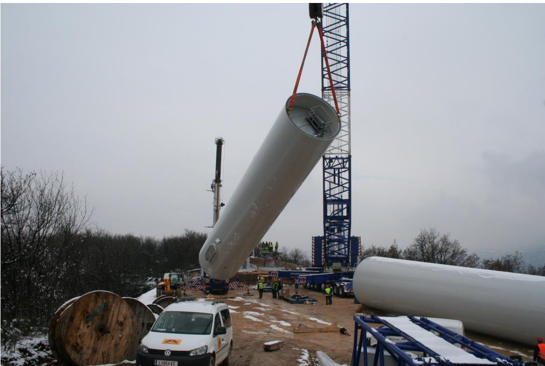
Figura 3. Smontaggio dei tronchi
