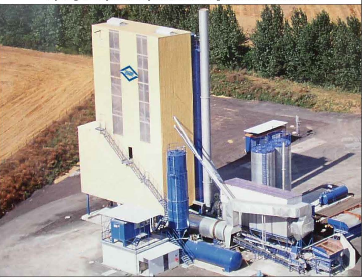
Tipologico impianto di produzione conglomerato cementizio
