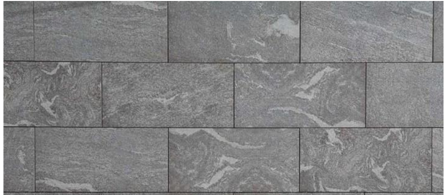
posa della pavimentazione a correre
