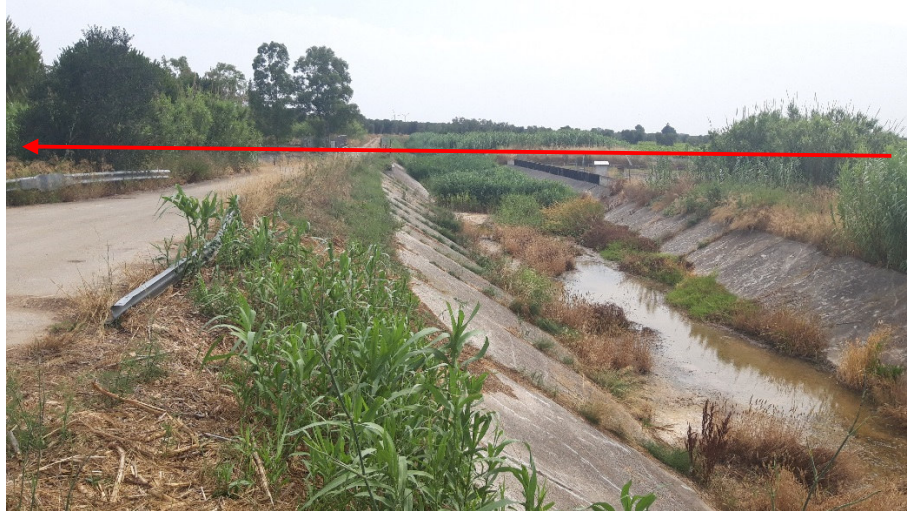
Foto 7 – Attraversamento Canale Foggia di Rau in TOC
