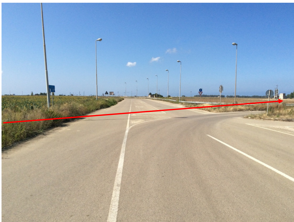
Foto 10 – Attraversamento con trivellazione spingitubo della S.P. n.88
