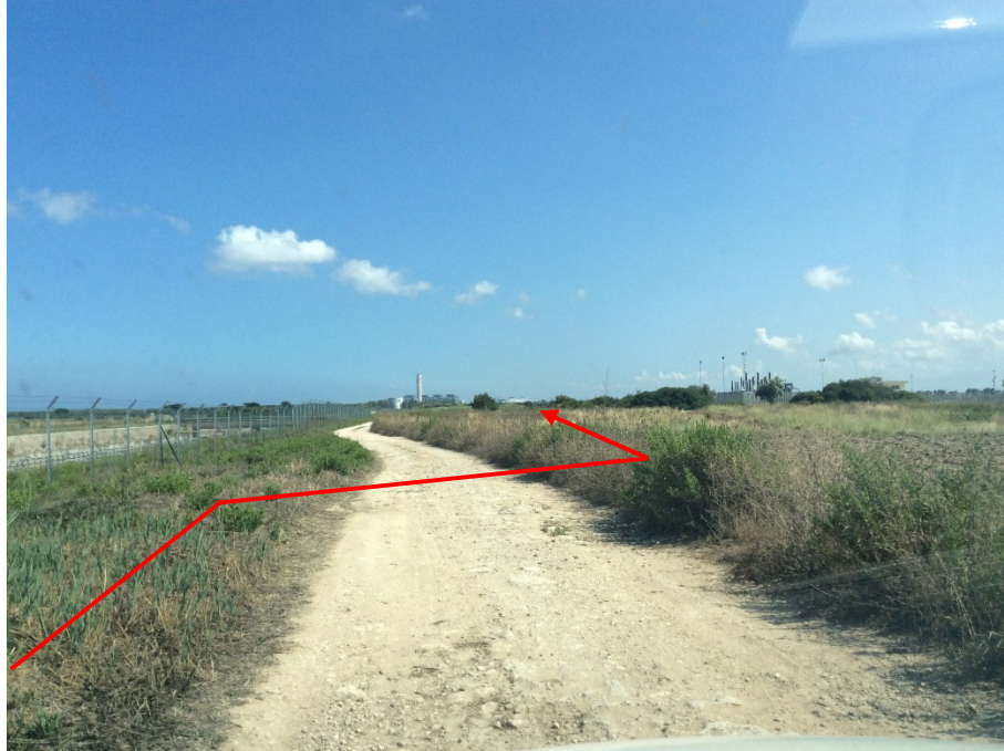
Foto 5 – Attraversamento della strada vicinale con scavo a cielo aperto
