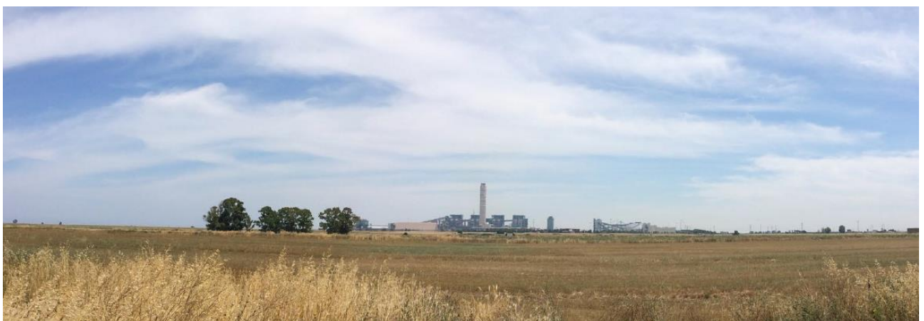
Figura 6.7.10 – Vista sulla Centrale da Nord-Est
