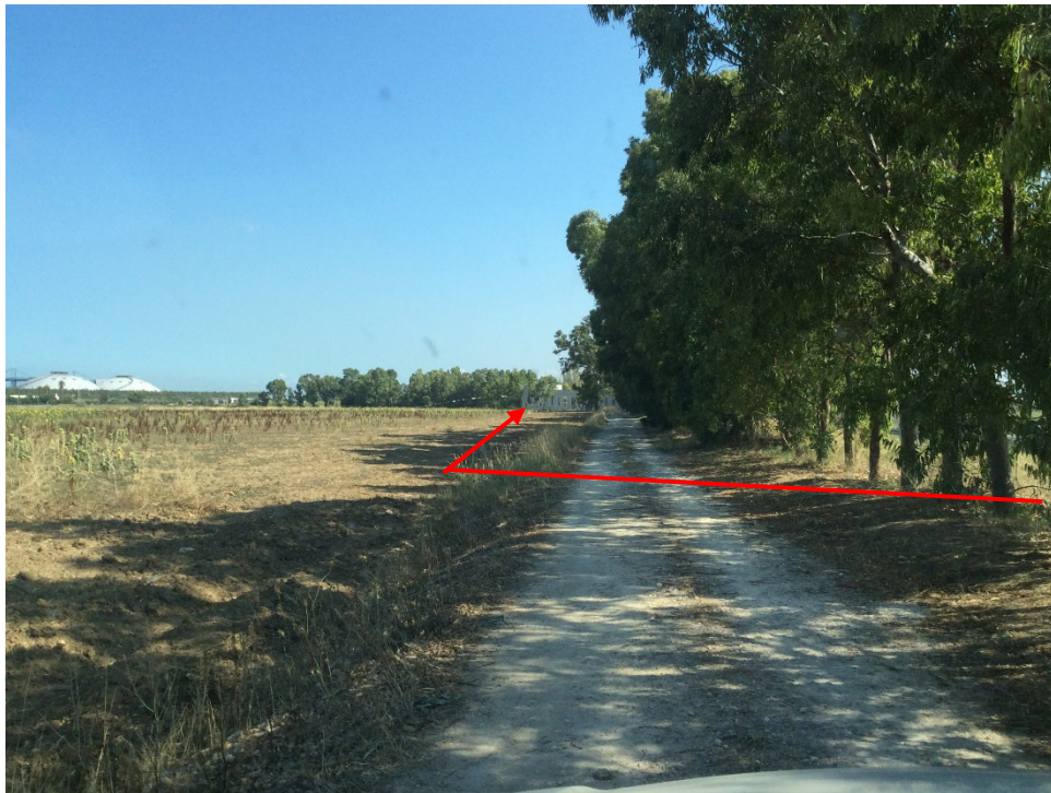
Foto 9 – Attraversamento Strada Comunale N.78 in TOC e proseguimento in parallelismo alla Strada Comunale con scavo a cielo aperto
