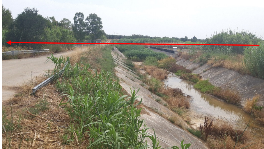
Foto 7 – Attraversamento Canale Foggia di Rau in TOC
