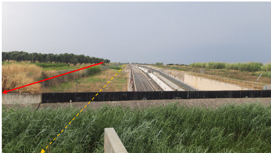
Foto 6 – Attraversamento Canale Foggia di Rau e uliveto in TOC con parallelismo Oleodotto DN 400 (16")
