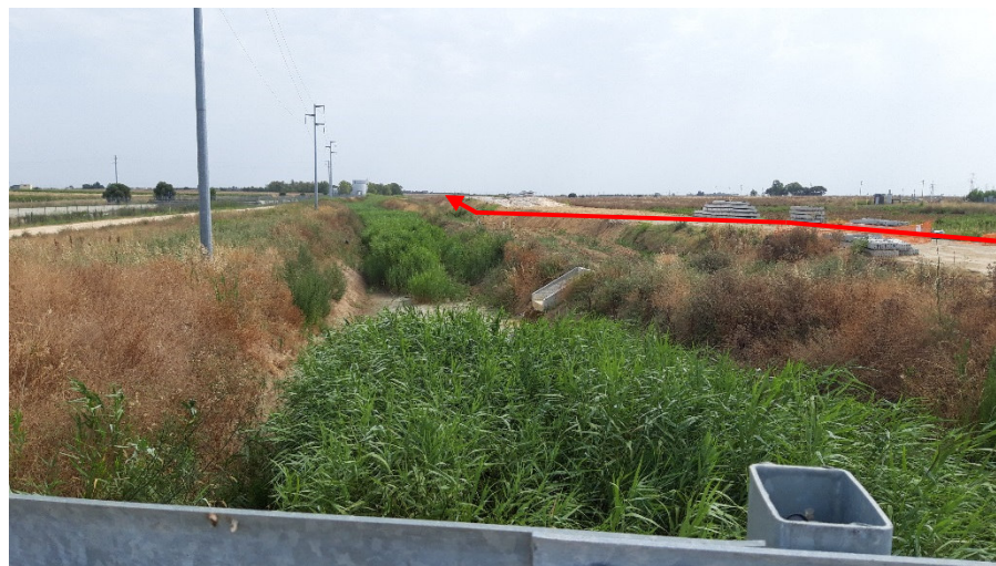
Foto 2 – Nuovo raccordo ferroviario Zona Retroportuale Brindisi-Rete RFI in costruzione
