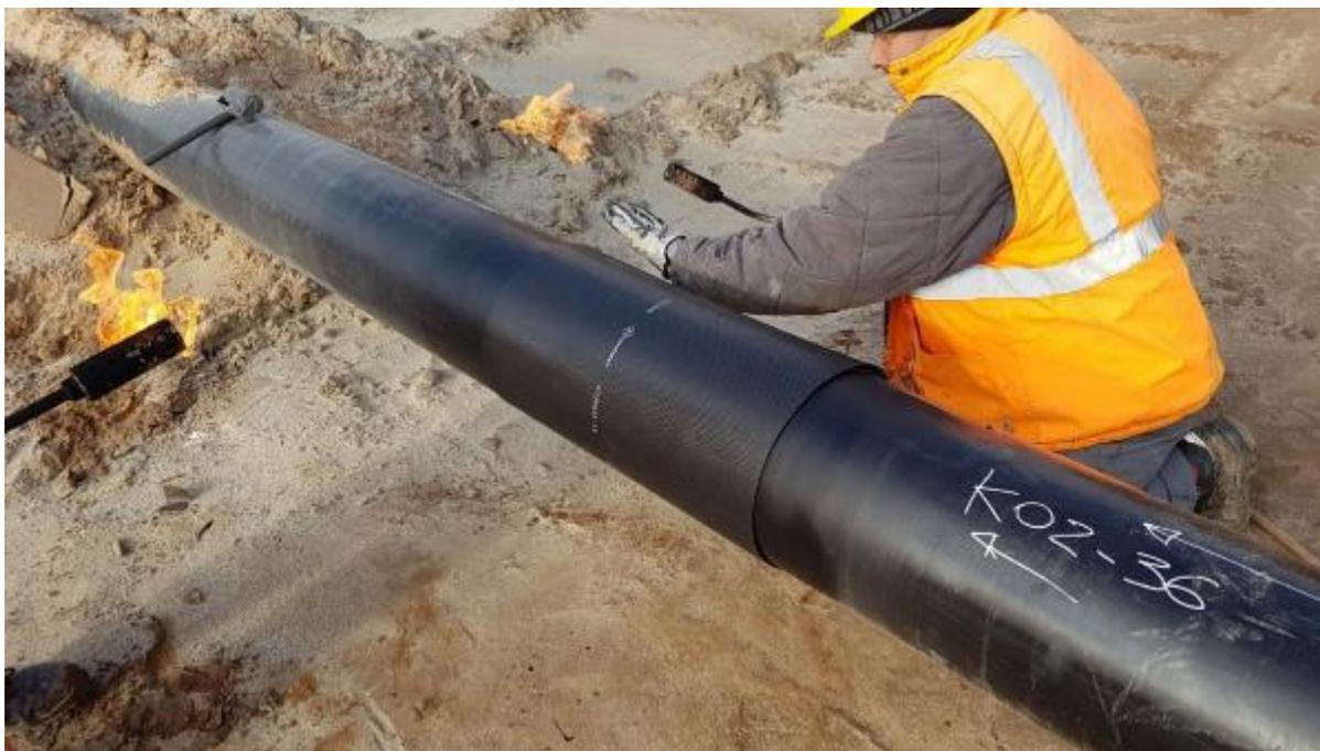
*Figura 3-9 – Applicazione di una fascia termorestringente su giunto di saldatura*
