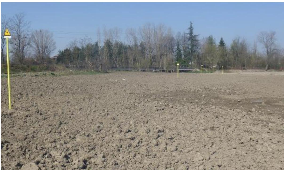
*Figura 3-17 – Pista lavori, su terreno agricolo, a ripristini ultimati; si nota la disposizione delle paline segnaletiche su metanodotto in esercizio*
