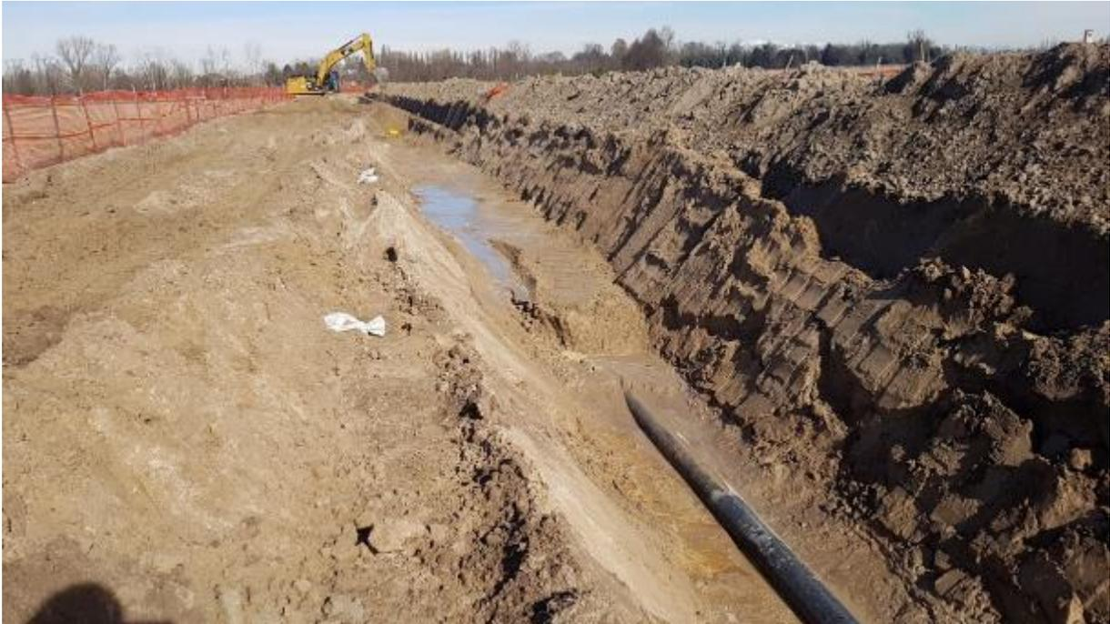
*Figura 3-11 – Operazioni di riinterro della condotta*
