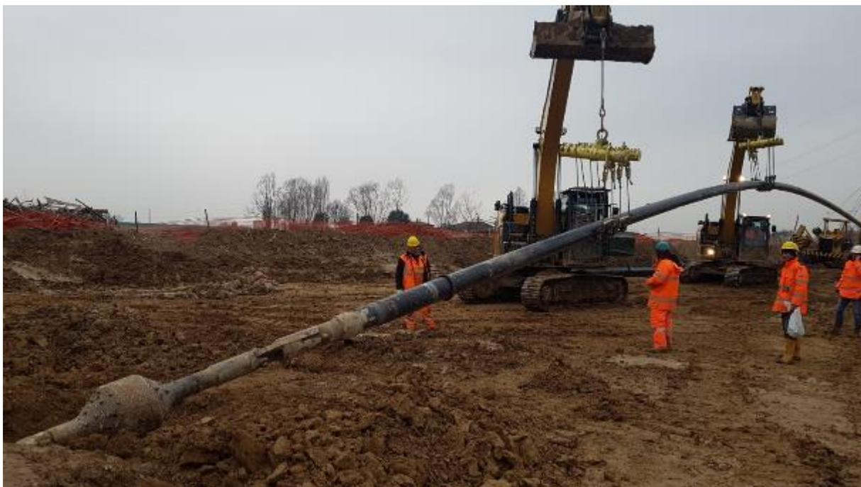
*Figura 3-15 – Esempio di operazione di varo della TOC*
