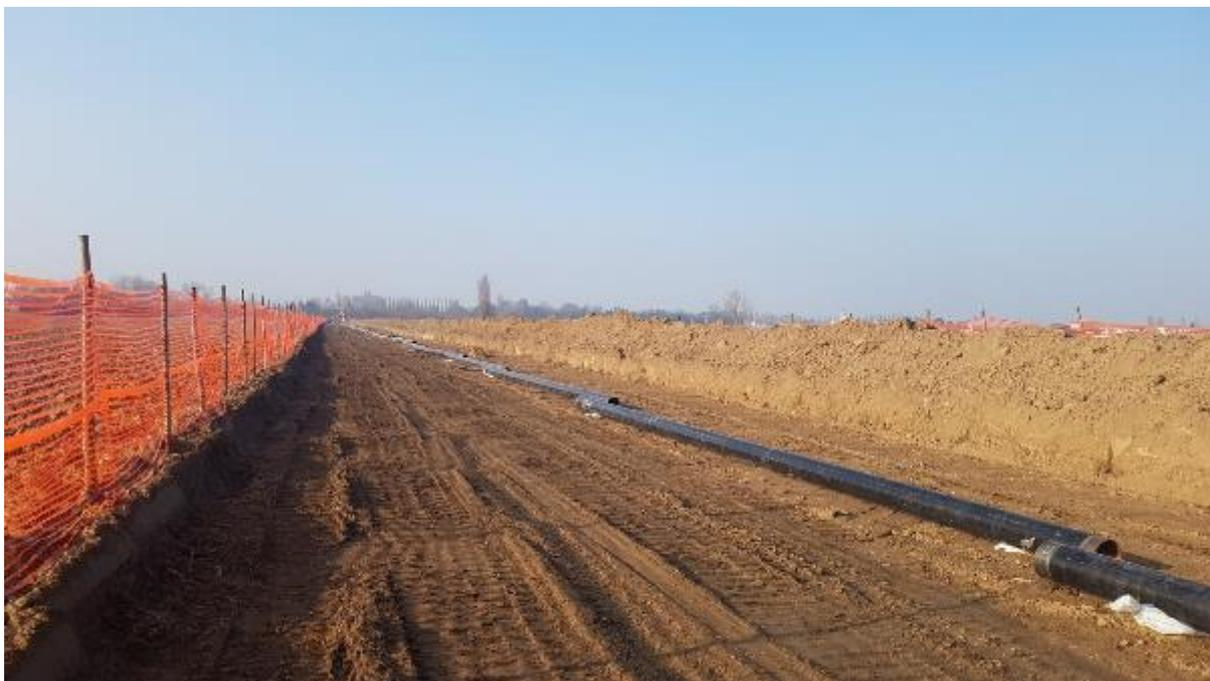
*Figura 3-6 – Sfilamento delle tubazioni di linea*
