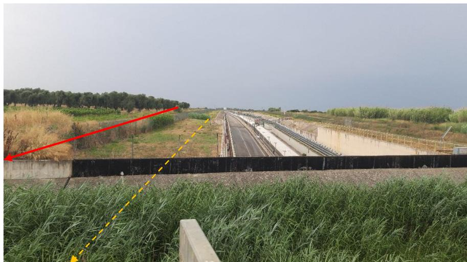
**Foto 6 – Attraversamento Canale Foggia di Rau e uliveto in TOC con parallelismo Oleodotto DN 400 (16")**
