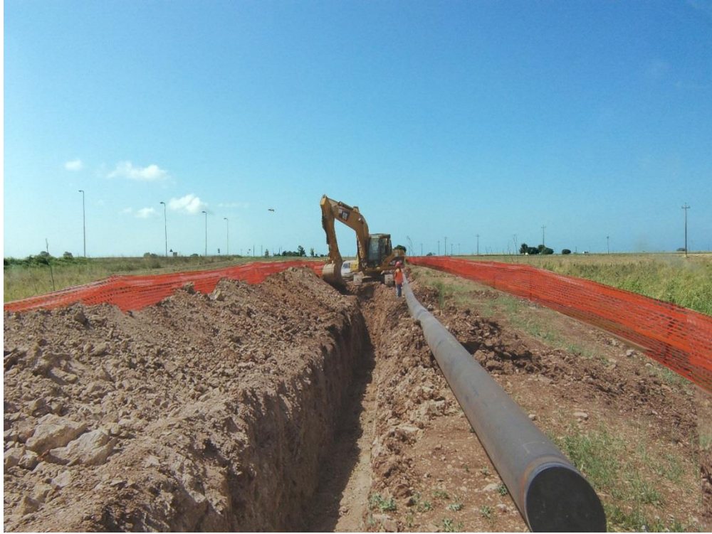
Foto 3: Cantiere in corso
