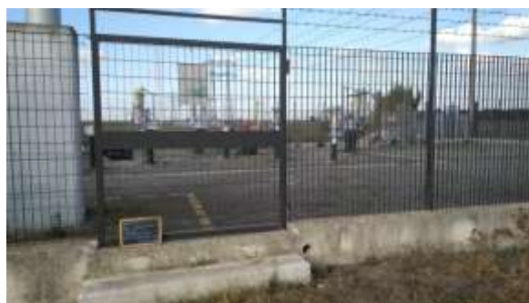
foto 4 p.la 159 Impianto PIDI
