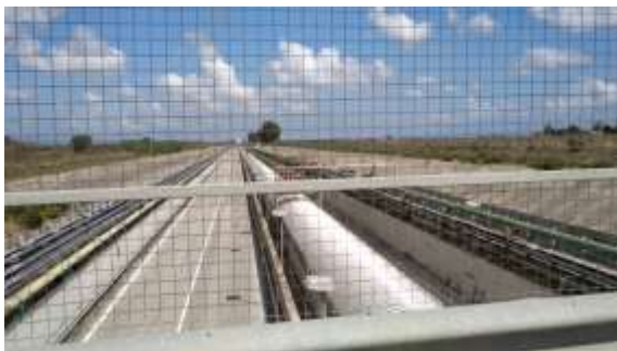
Foto 48 Attraversamento in T.O.C
