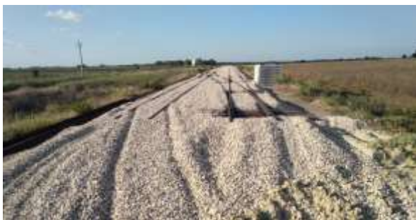
Foto 11 Asse ferroviario in costruzione
