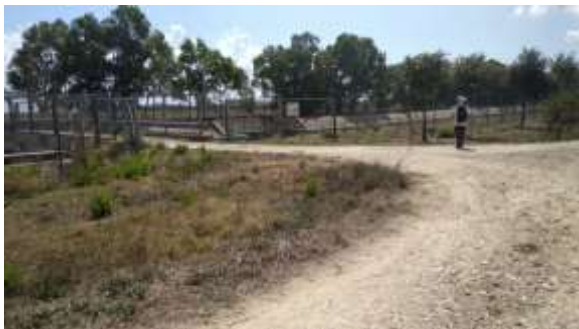
Foto 46 Attraversamento in T.O.C.
