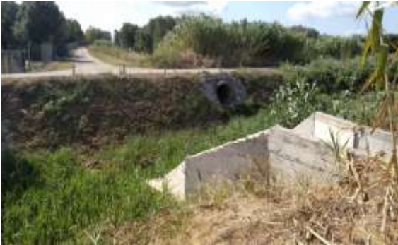
Foto 36 Canale Foggia di Rau
