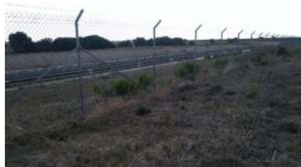
foto 29 p. privata: Asse Attrezzato Policombustibile
