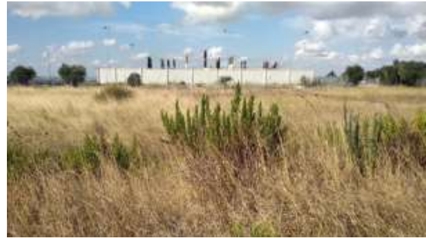
foto 27 p.lla75 in lontananza campo fotovoltaico
