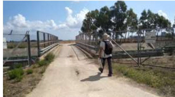
foto 47 Attraversamento in T.O.C.
