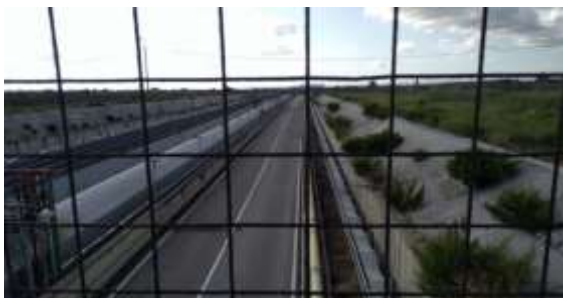
Foto 17 p. privata Asse Attrezzato Policombustibile
