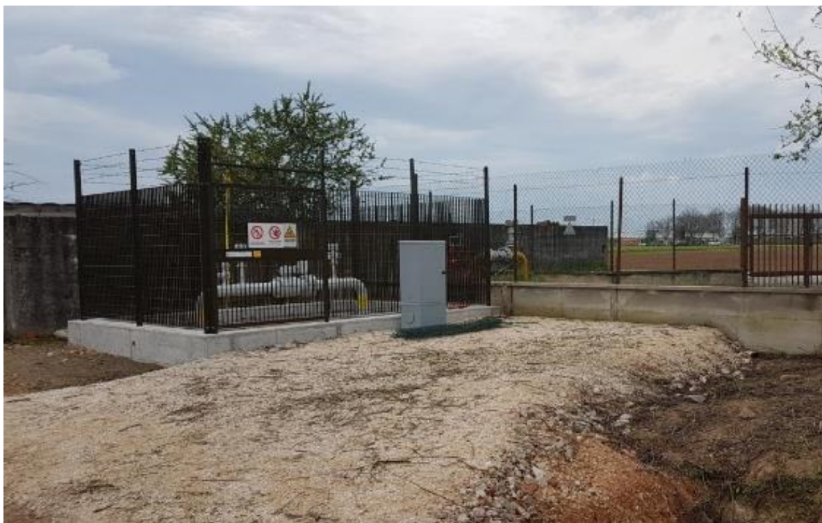
Figura 5.1-4 – Esempio di impianto al termine dei lavori
