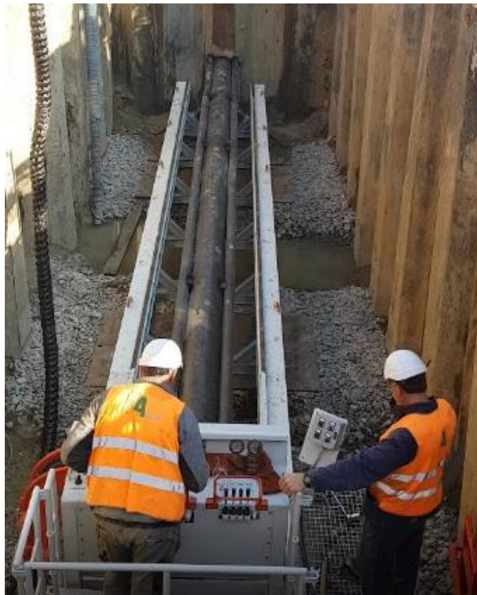
Figura 5.1-1 – Esecuzione di trivellazione spingitubo
