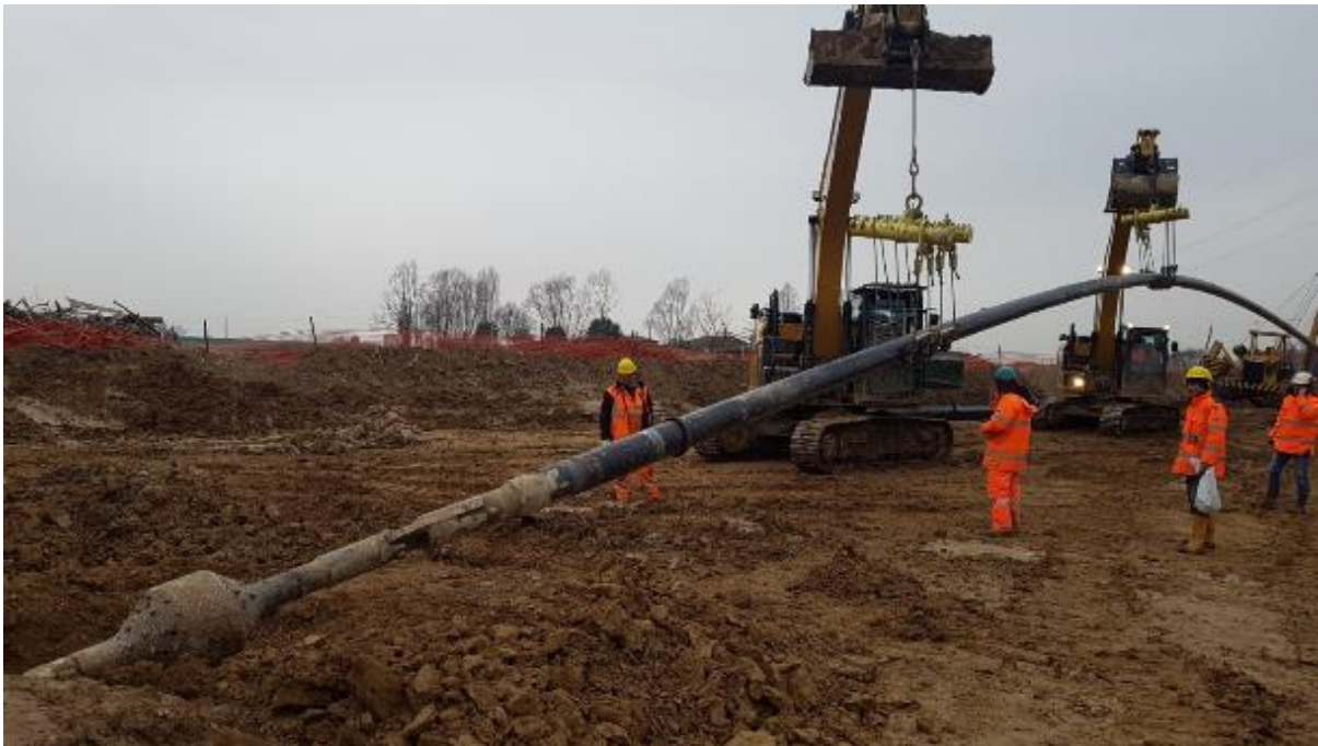
Figura 5.1-3 – Esempio di operazione di varo della TOC
