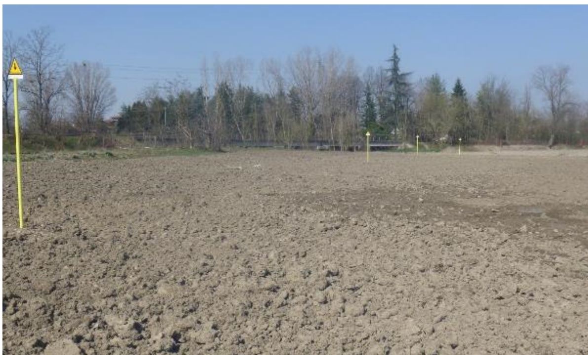
Figura 5.1-5 – Pista lavori, su terreno agricolo, a ripristini ultimati; si nota la disposizione delle paline segnaletiche su metanodotto in esercizio
