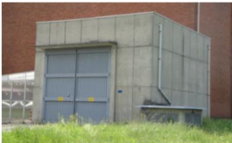
Figura 2-5. Panoramica della piscina del combustibile esausto. Accesso esterno
