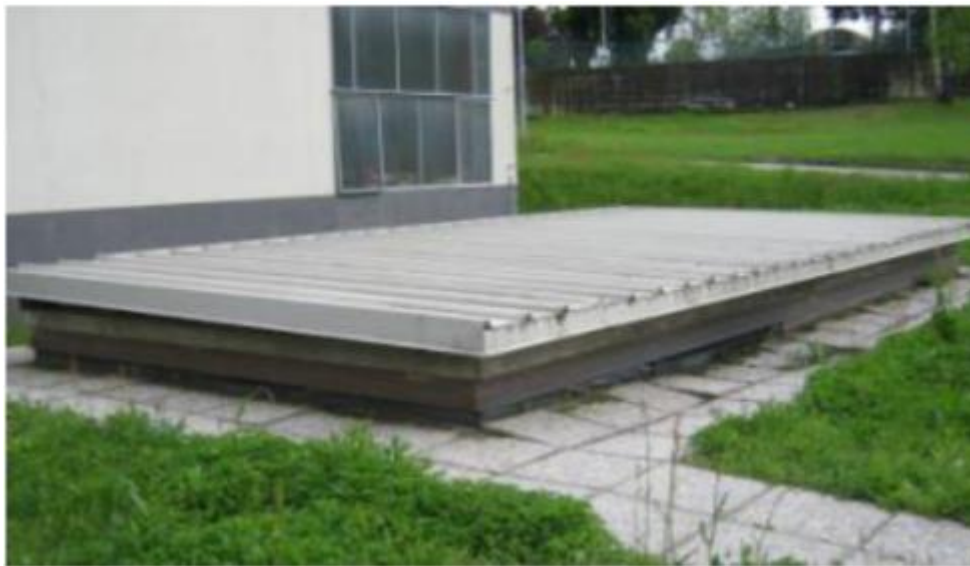
Figura 6-4: Copertura del serbatoio Diesel interrato
