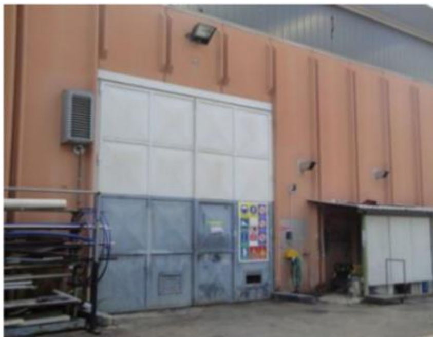
Figura 11-3. Edificio 99 – Porta di accesso all'officina
