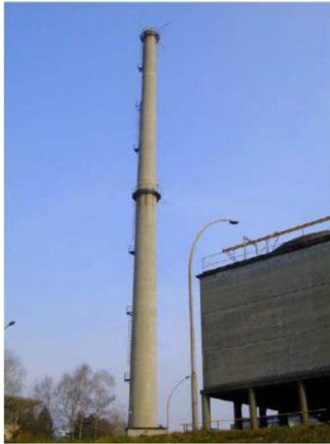
Figura 9-1 Edificio 88 – Camino di ventilazione
