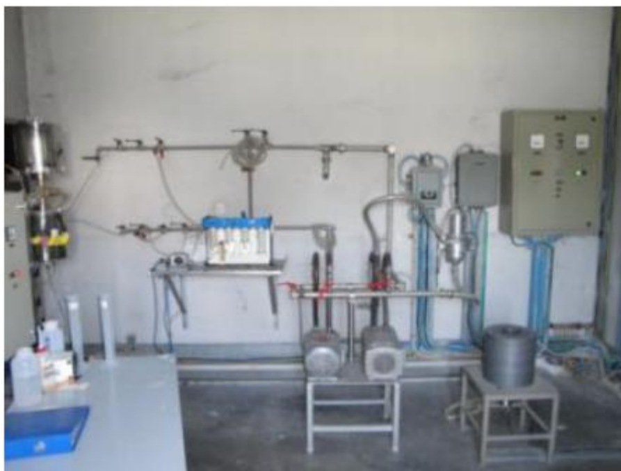
Figura 9-3. Edificio 88 – Vista interna della sala 7202.
