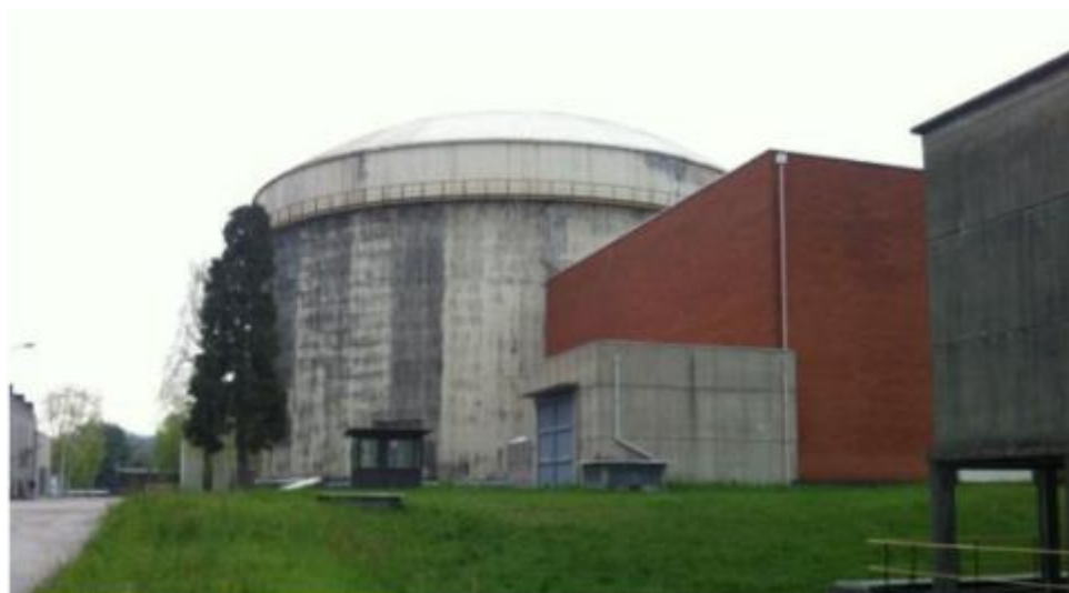
Figura 1-2. Edificio 80 – Struttura di contenimento
