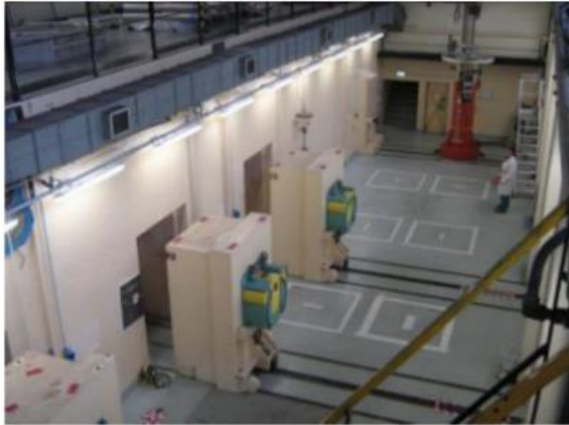
Figura 2-13. Laboratorio ADECO – Area sul retro delle celle
