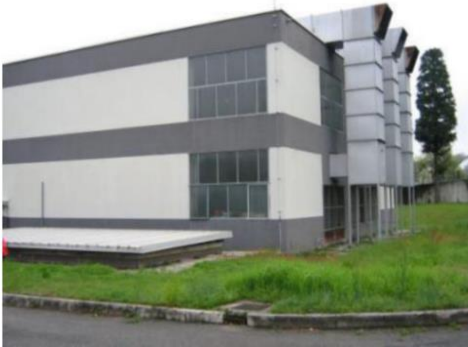
Figura 6-1: Edificio 85. Sala Diesel
