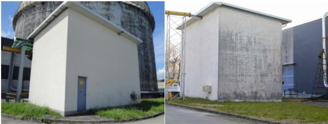
Figura 8-5. Edificio 87e - Stazione di stoccaggio intermedia per liquidi radioattivi
