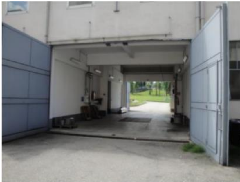
Figura 4-2: Accesso alla corte interna sud di ESSOR
