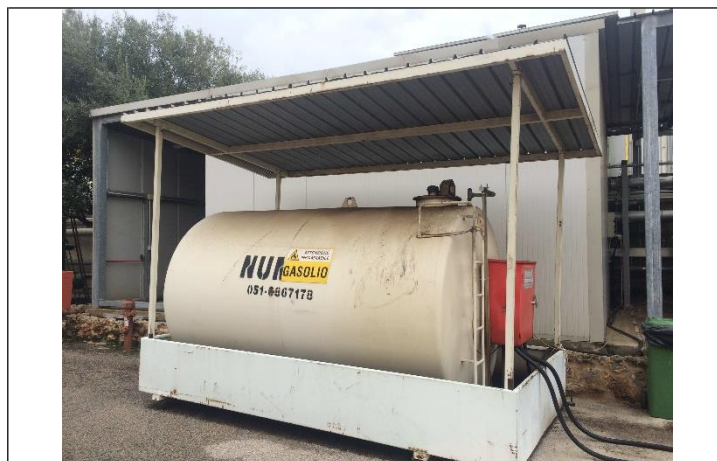
Figura 4 Stoccaggi gasolio BL1 da 9 m 3
