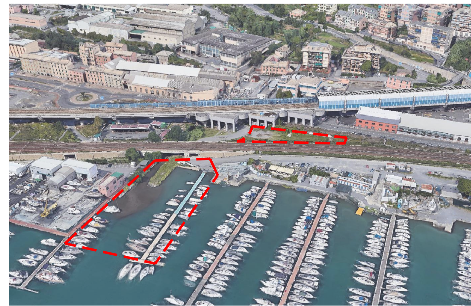
Vista aerea dell'ambito di intervento Pescatori
