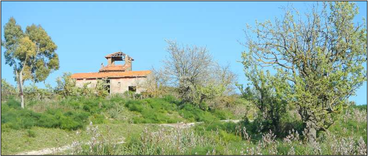
Foto 3 rudere lungo la strada di accesso ai siti
