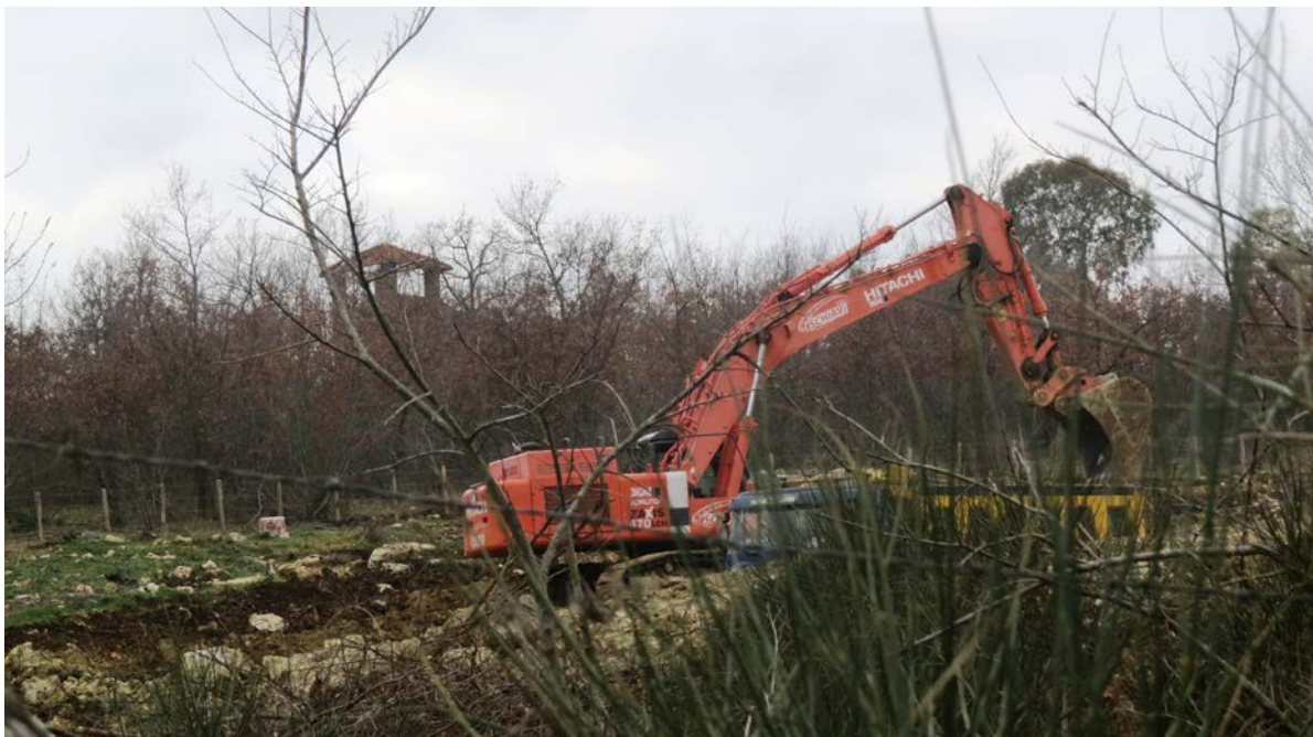
FAU/11 – Zona di cantiere con sito di monitoraggio sullo sfondo
