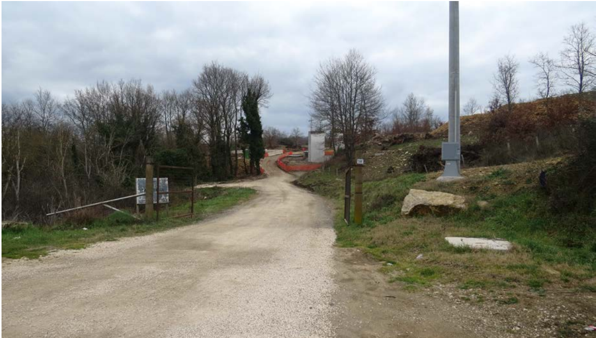
FAU/11 – Strada di accesso al sito di monitoraggio conducente al "tiro a volo ASD T.A.V. Vetralla"
