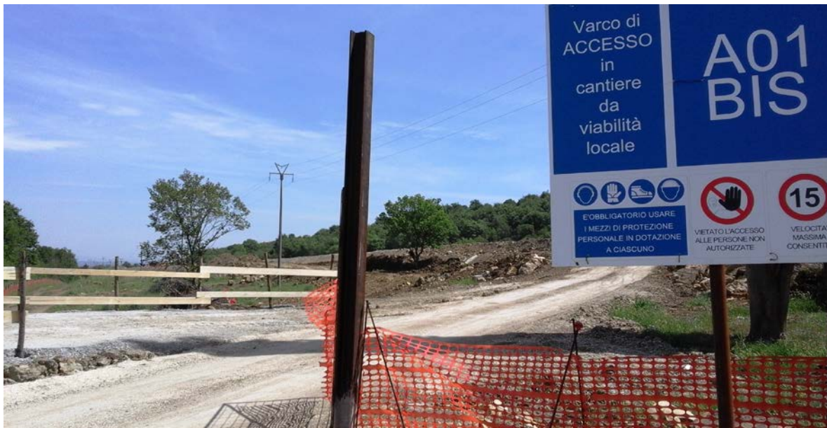
FAU/20 – Varco di accesso dalla SS1Bis per il raggiungimento del sito di monitoraggio
