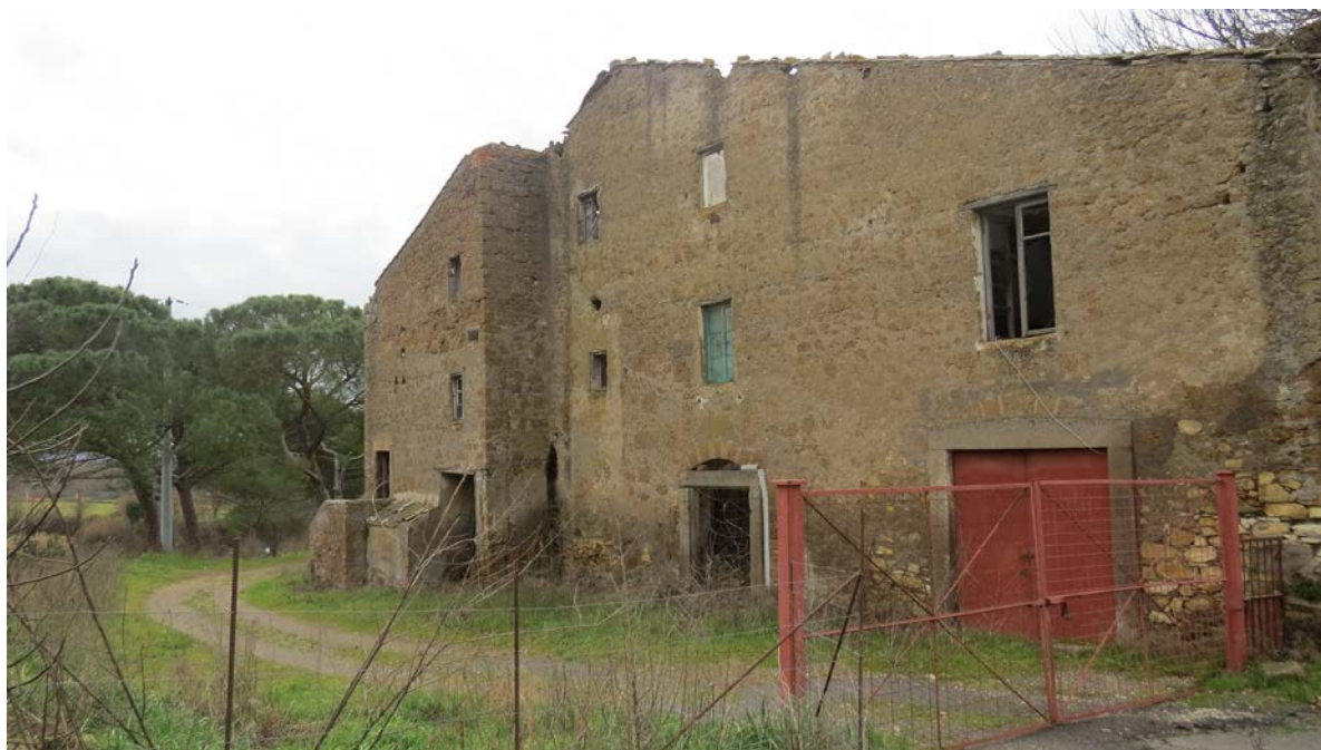
FAU/13 –Cascinale di ingresso all'area di monitoraggio
