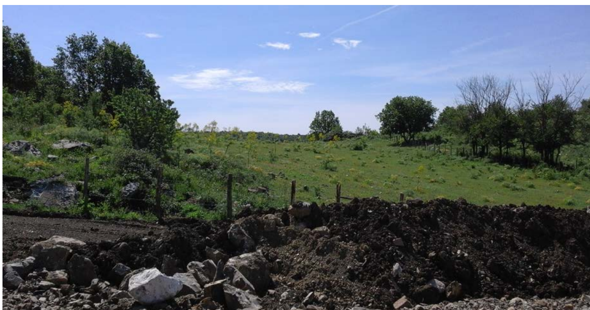
FAU/22 – Panoramica del sito – vista dal margine del cantiere
