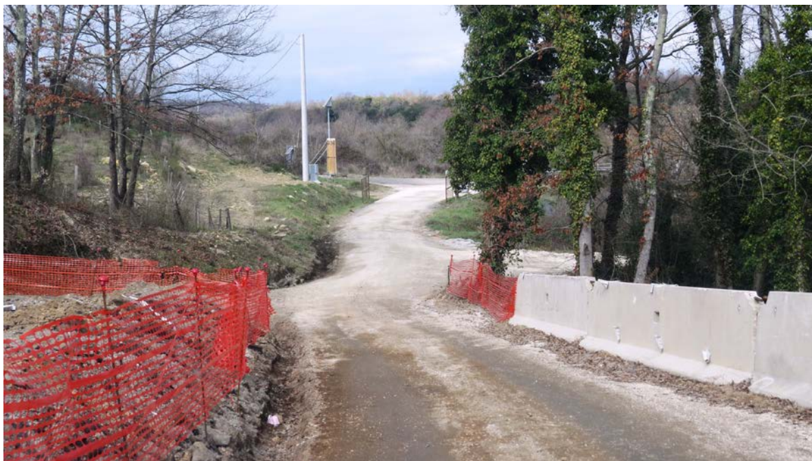
FAU/12 – Strada di accesso al sito di monitoraggio
