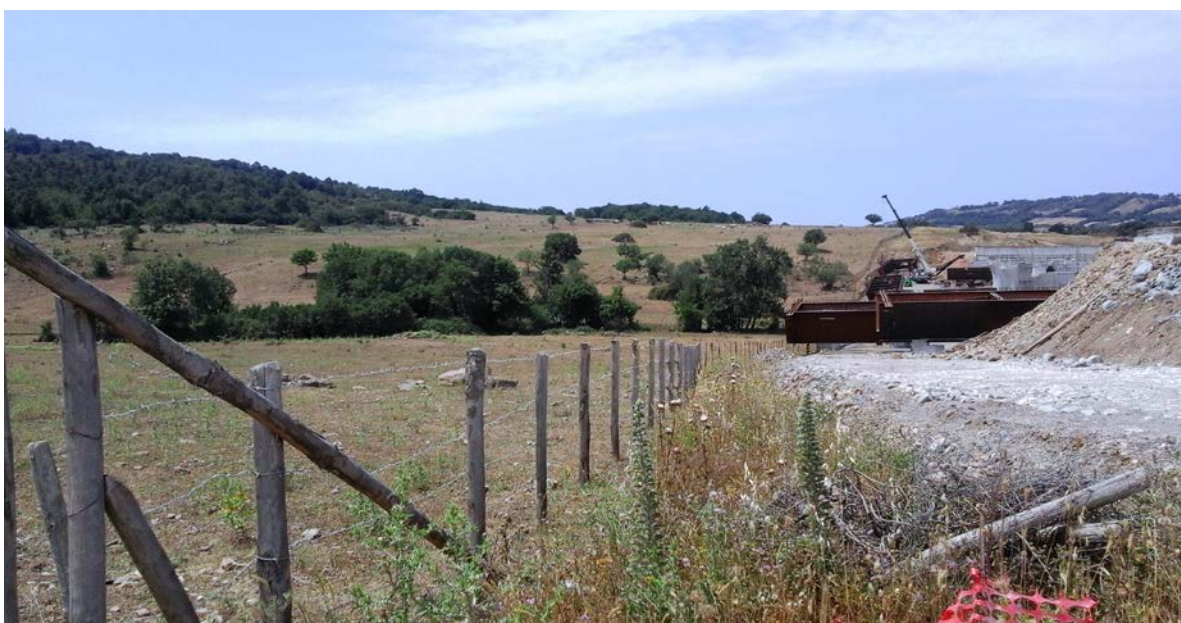
FAU/21 – Panoramica laterale del sito con vista sul cantiere
