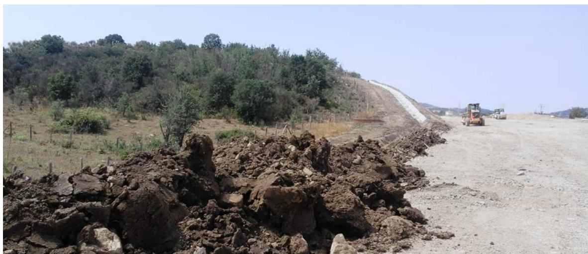
FAU/22 – Panoramica del sito – vista dal margine del cantiere
