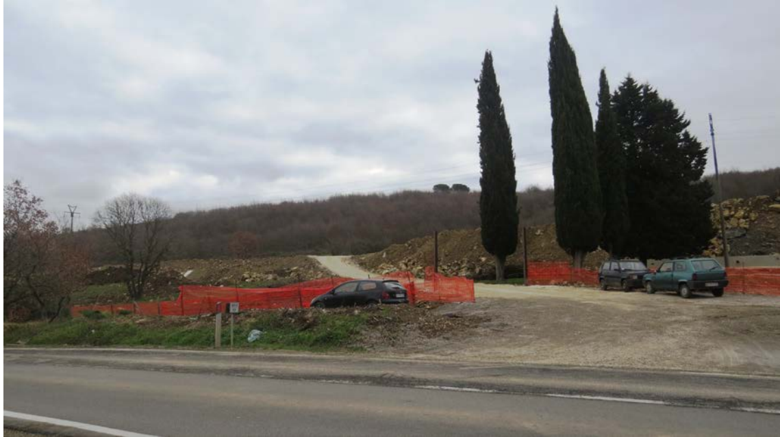
FAU/09 – Panoramica del sito e del punto di accesso al cantiere
