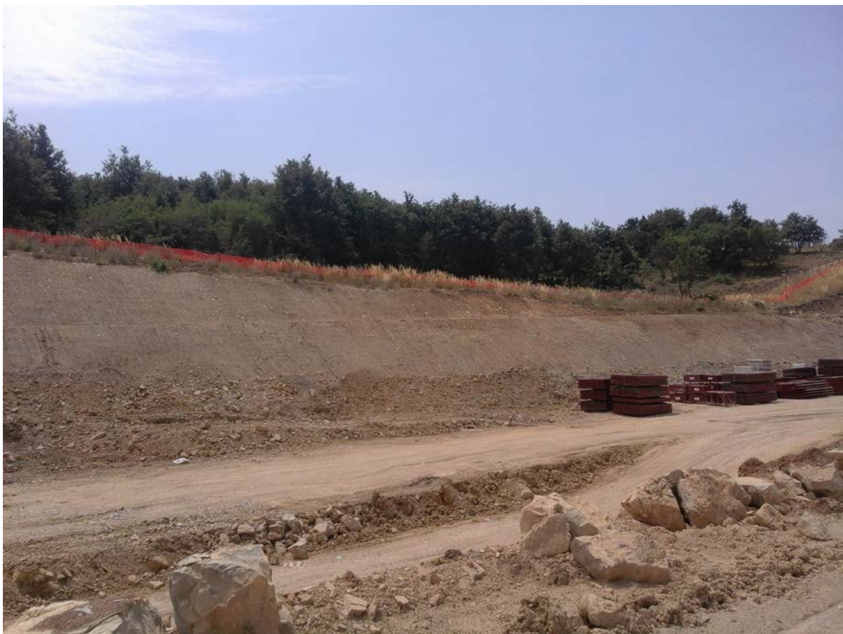
FAU/09 – Panoramica del sito vista dal cantiere
