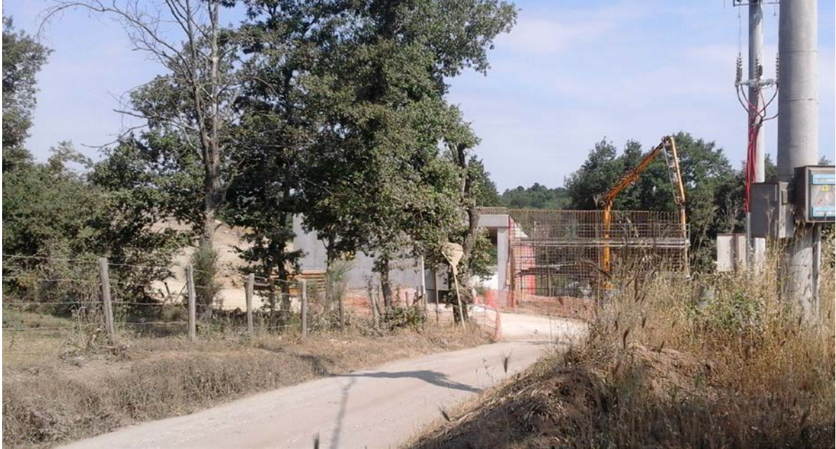
FAU/12 – Vista sul cantiere dalla strada di accesso al sito
