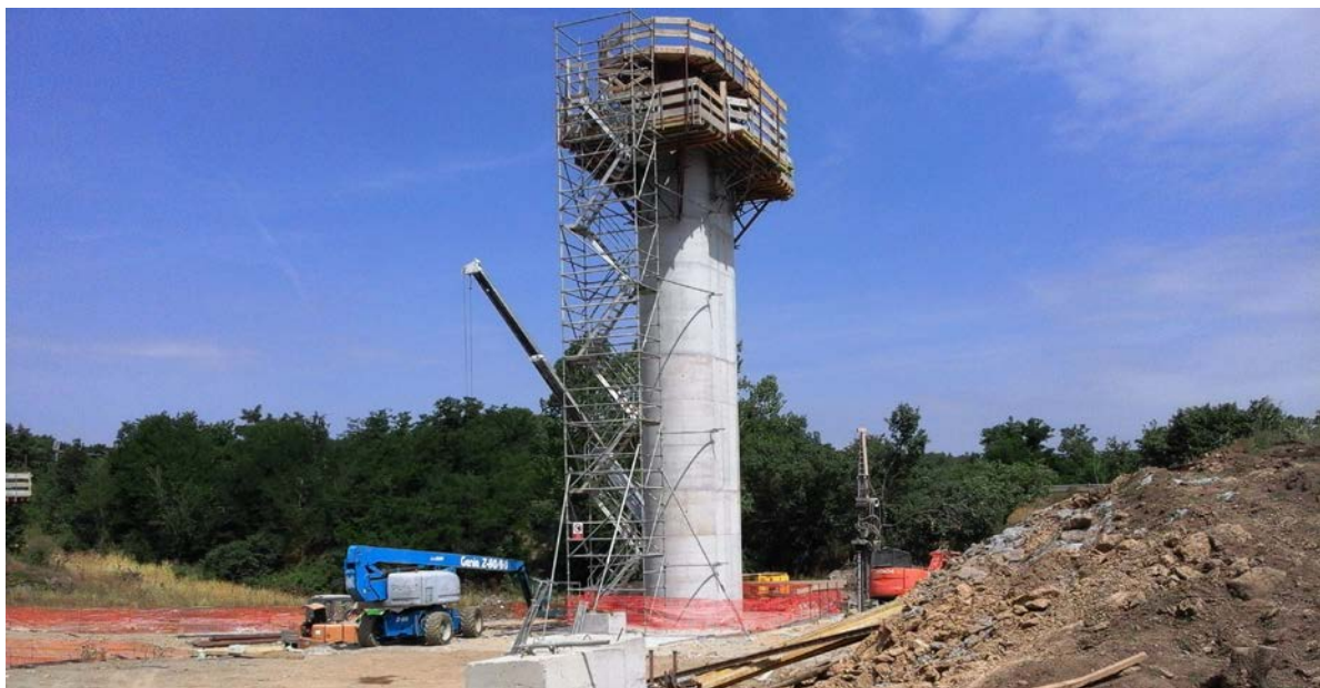
FAU/10 – Visuale dal cantiere
