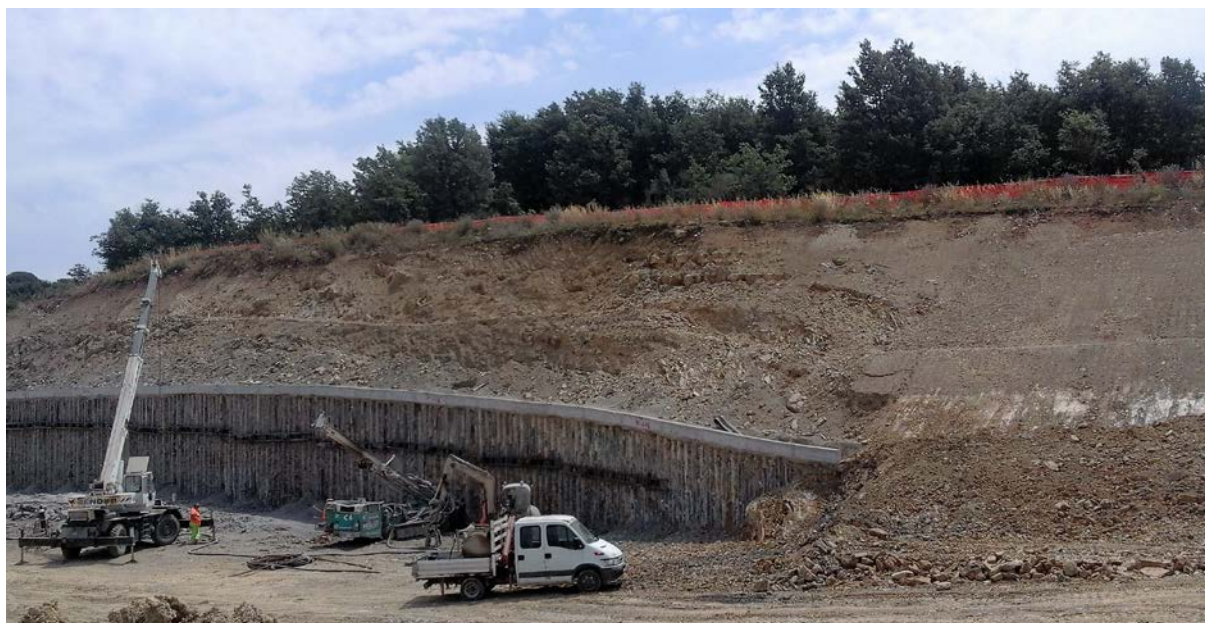
FAU 09 – Panoramica del sito vista dal cantiere
