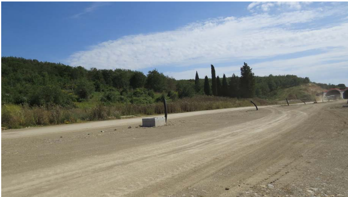
FAU/20 – Visuale sul sito di monitoraggio dal cantiere
