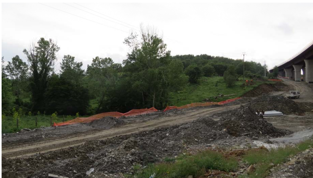
FAU/10 – Vista sulla fascia boscata dalla recinzione lato cantiere
