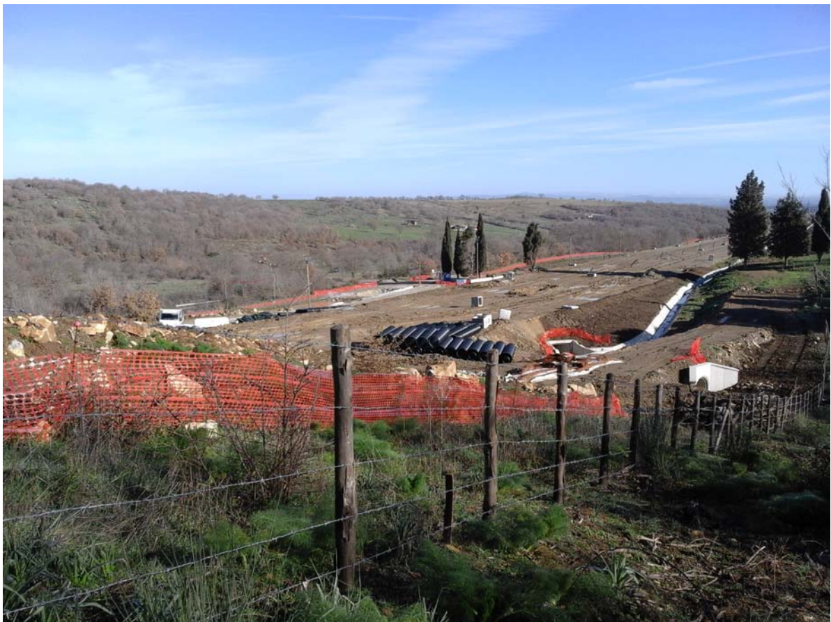
FAU/09 – Panoramica dal sito di monitoraggio con vista sul cantiere
