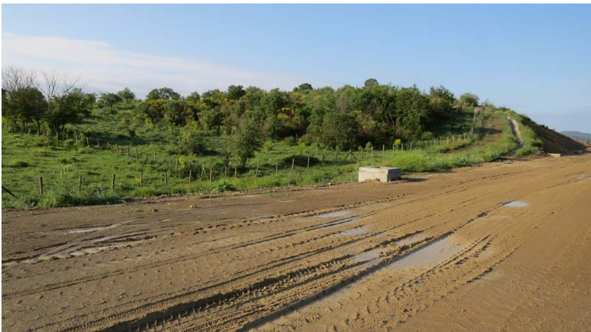
FAU/22 – Panoramica del sito – vista dal margine del cantiere
