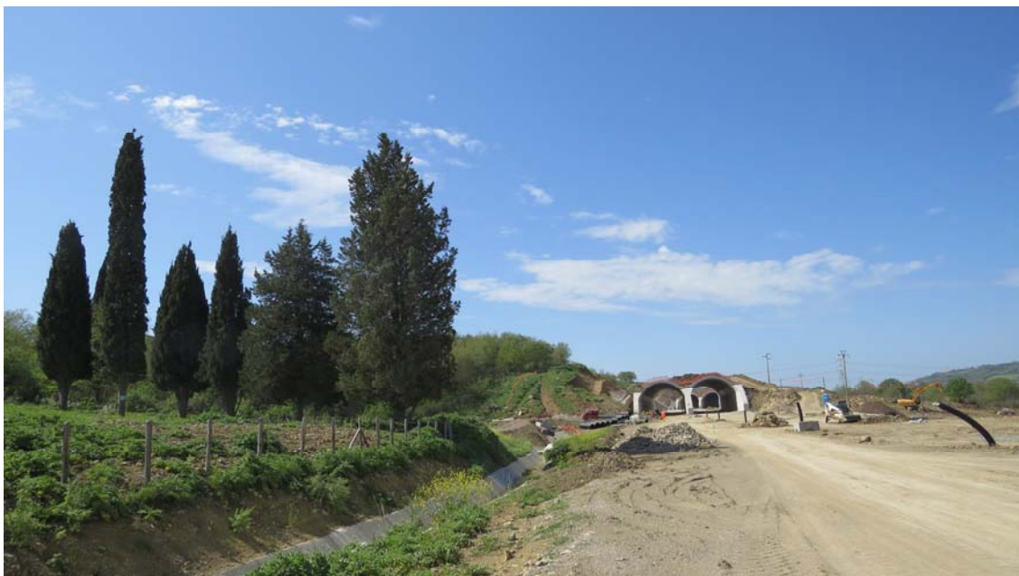
FAU/09 – Vista laterale alla zona di cantiere
