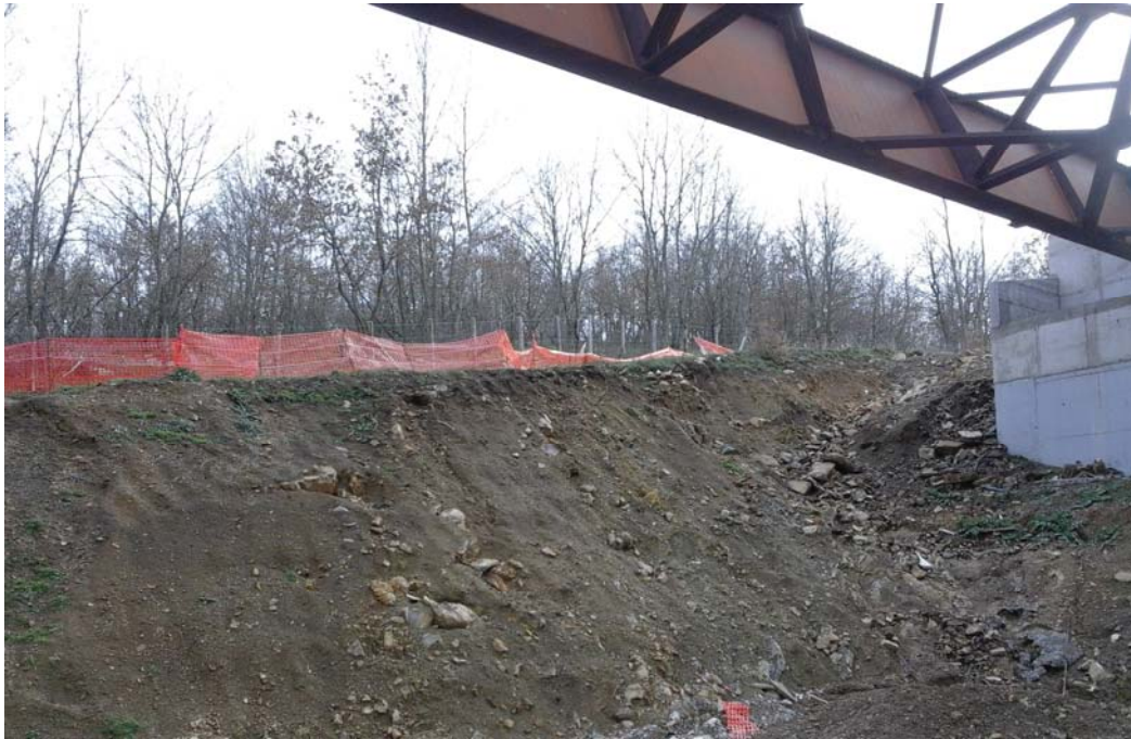
FAU/10 – Vista da un punto di osservazione interno al cantiere
