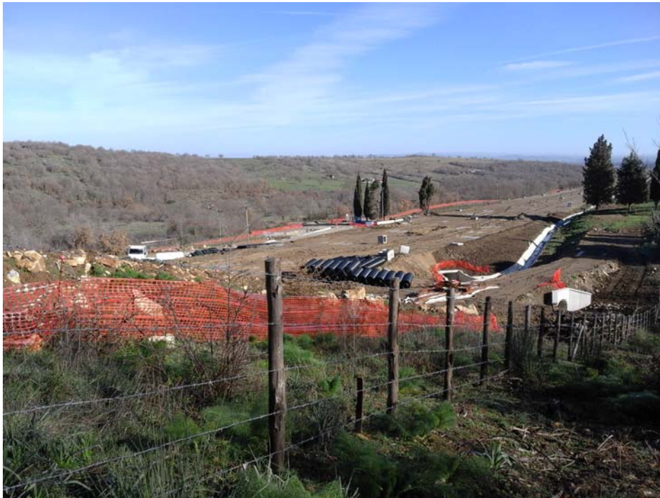
FAU/20 – Visuale sul cantiere
