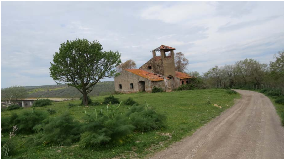
FAU/11 – Vista laterale all'adiacente area boschiva
