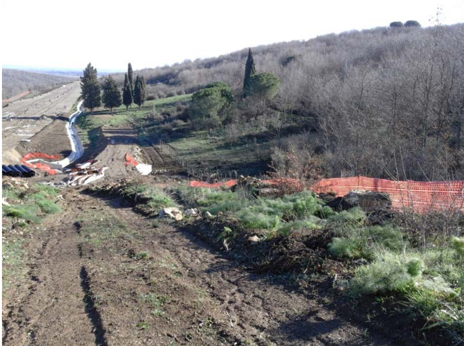
FAU/20 – punto di dal sentiero di accesso dal cantiere
