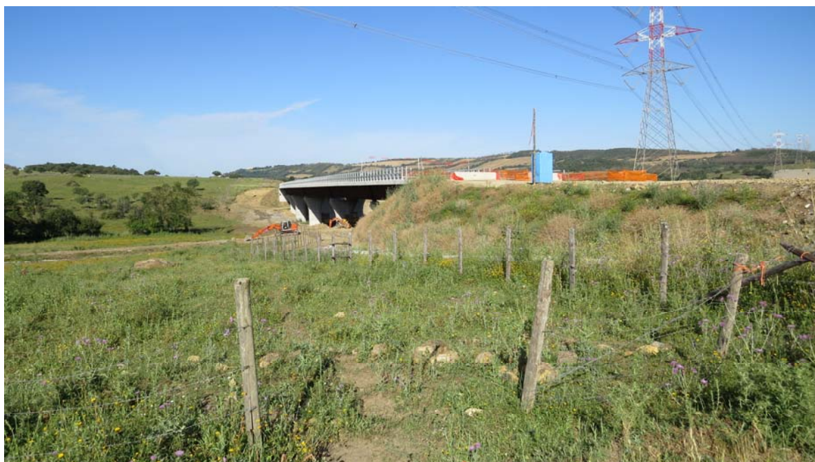
FAU/21 – Panoramica con vista sul cantiere
