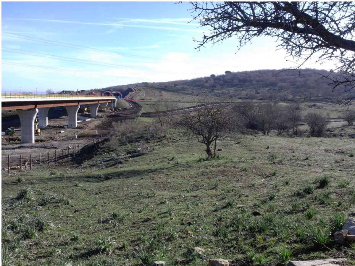
FAU/21 – Panoramica con vista sul cantiere
