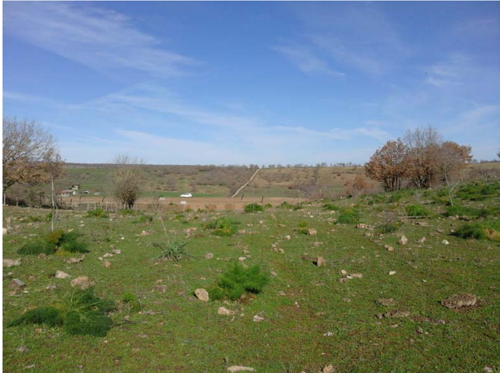
FAU/22 – Panoramica del sito con vista sul cantiere
