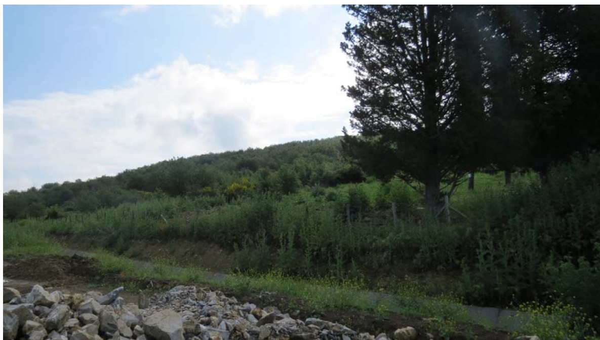
FAU/20 – Panoramica della zona di monitoraggio
