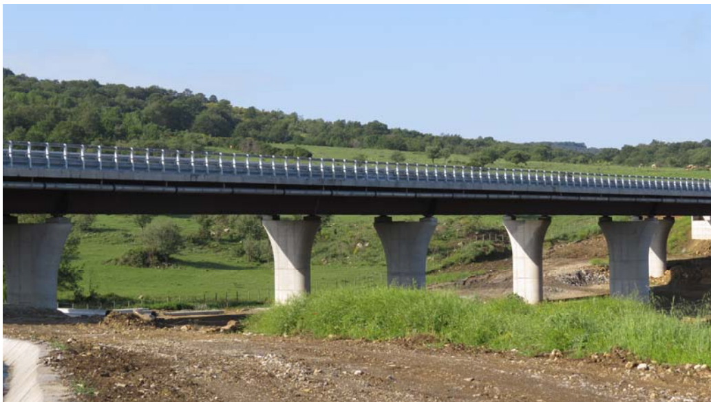
FAU/21 – Panoramica del sito con vista retrostante al cantiere
