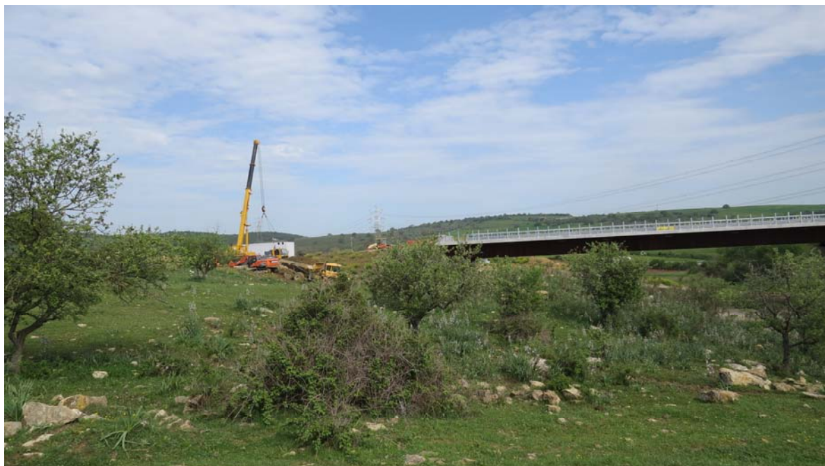
FAU/21 – Panoramica con vista sul cantiere
