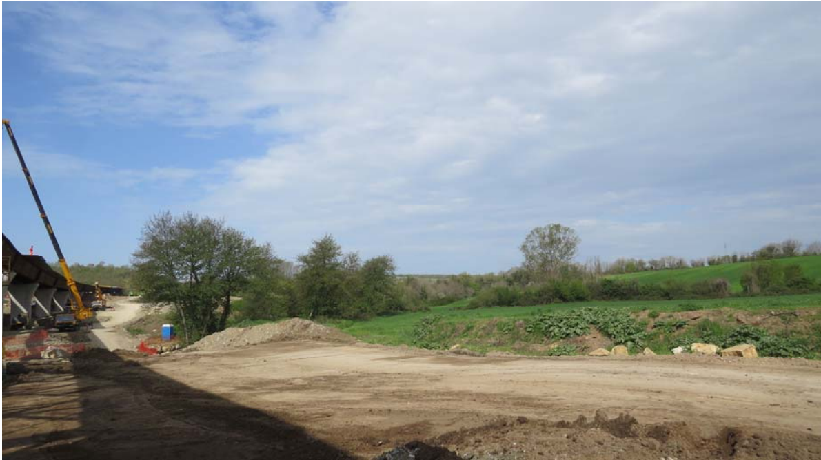
FAU/13 – Fascia ripariale con campo agricolo sulla destra e cantiere sulla sinistra
