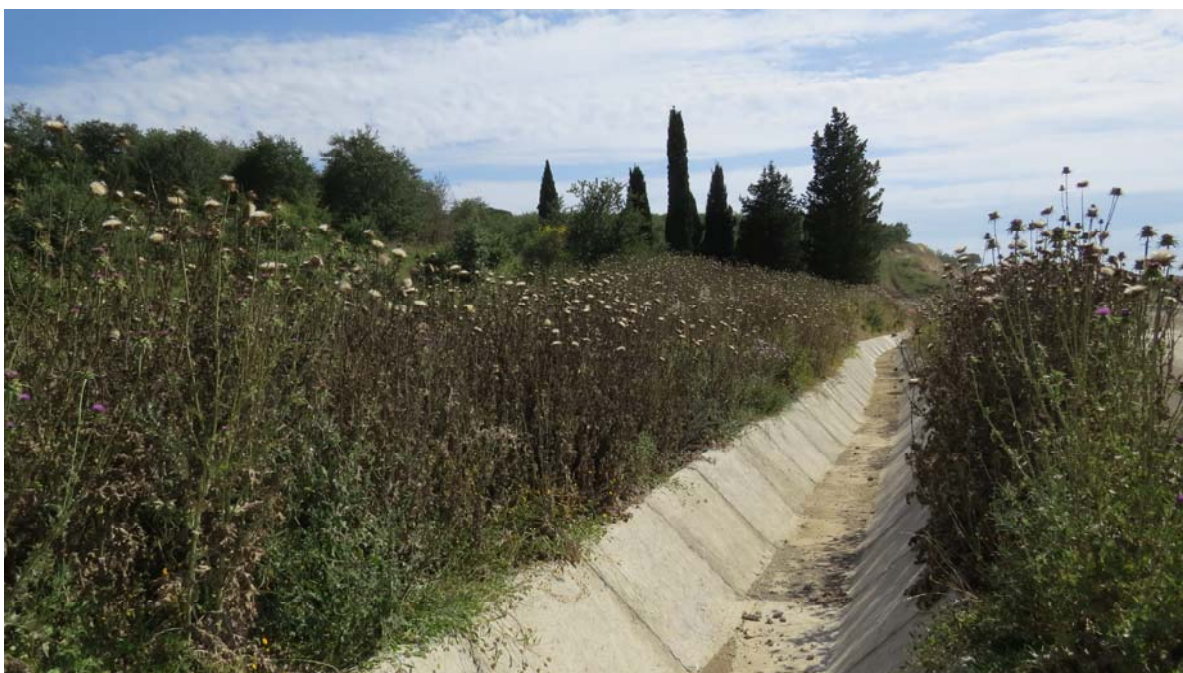
FAU/20 – Margine sinistro del cantiere verso la zona di monitoraggio
