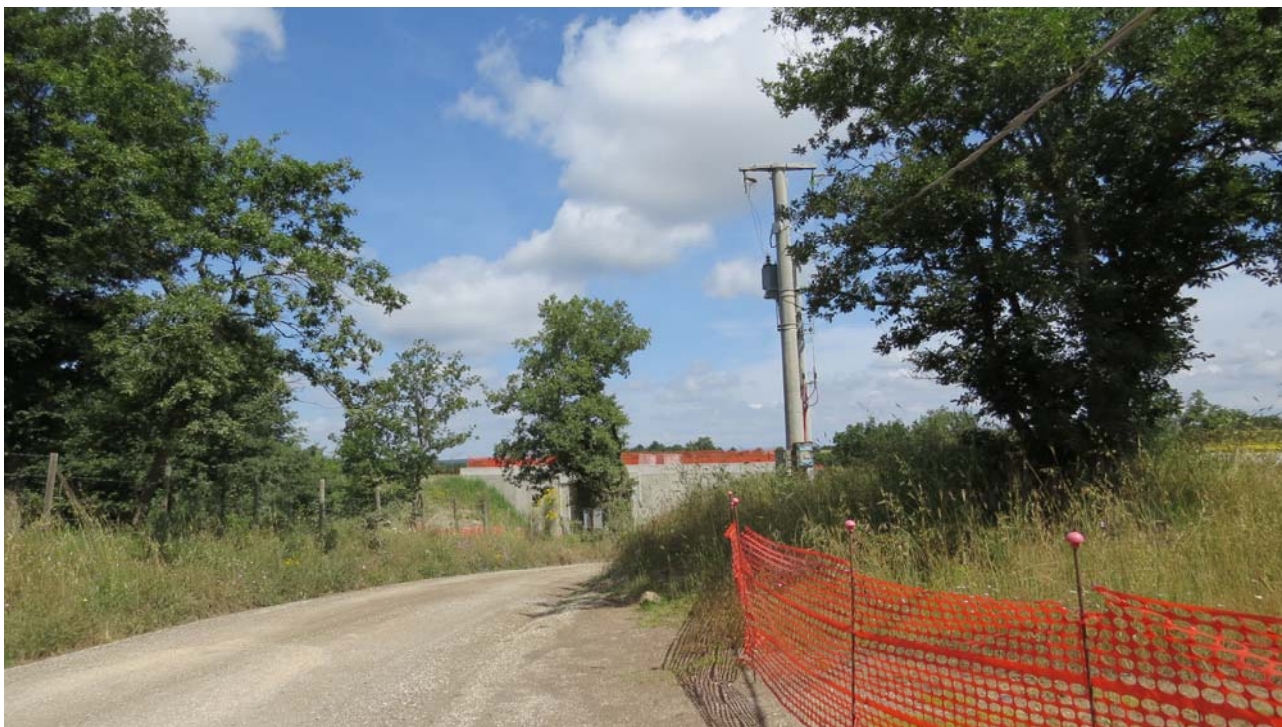
VEG 38 – Visuale sul cantiere dall'area di monitoraggio
