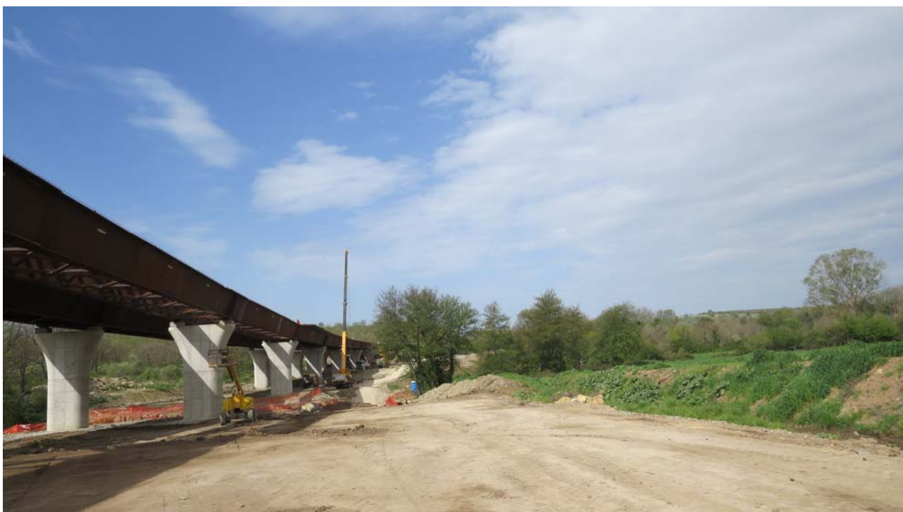
VEG 39 – Visuale lato cantiere
