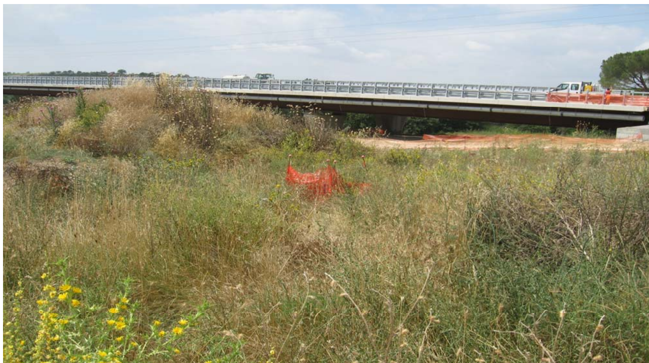
VEG28 – Visuale della zona di monitoraggio a margine delle operazioni di costruzione
