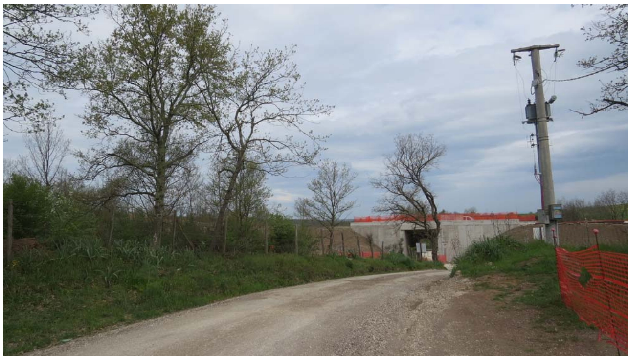
VEG 38 – visuale sul cantiere dal punto di ingresso al sito
