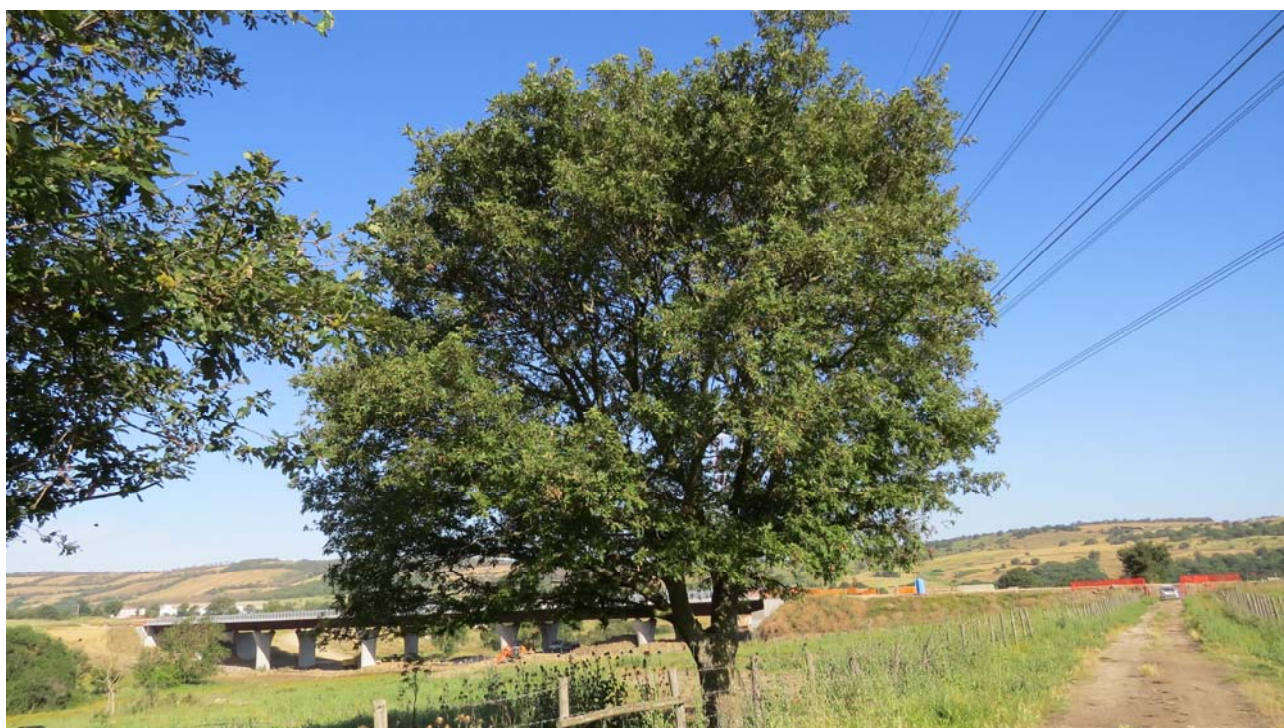
VEG28 – Visuale del cantiere dall’interno della zona di monitoraggio
