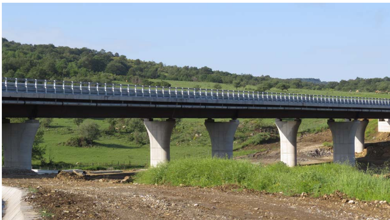
VEG28 – Visuale sulla zona di monitoraggio vista dalla zona retrostante al viadotto costruito
