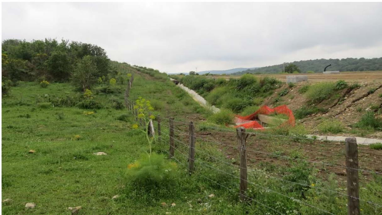
VEG 32 – Visuale dall'area vista con vista sul cantiere
