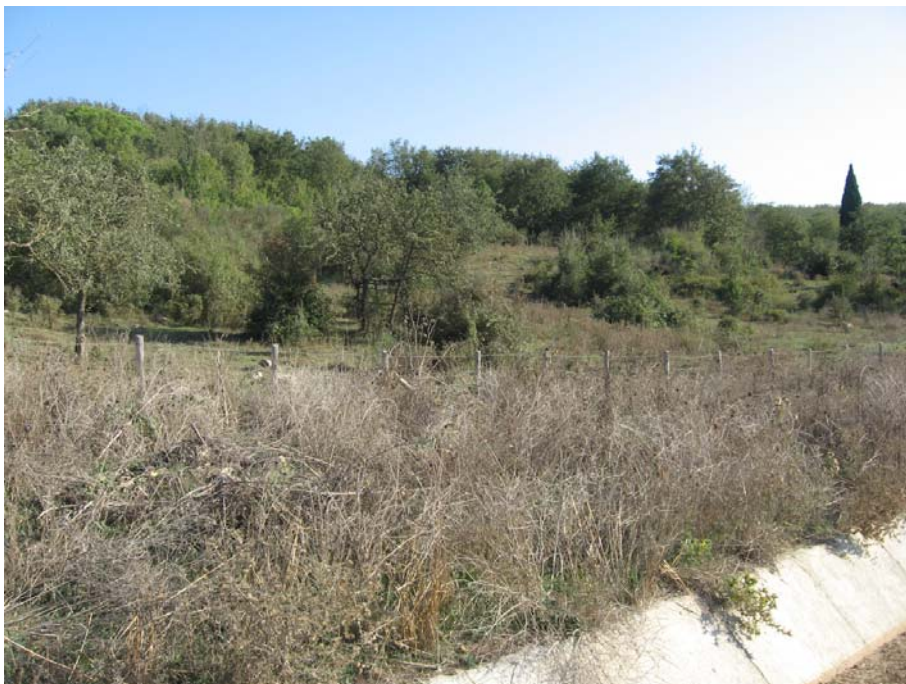
FAU/20 – Margine sinistro del cantiere verso la zona di monitoraggio
