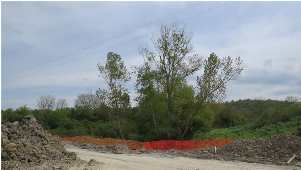
VEG 35 – Visuale da punto di osservazione interno al cantiere
