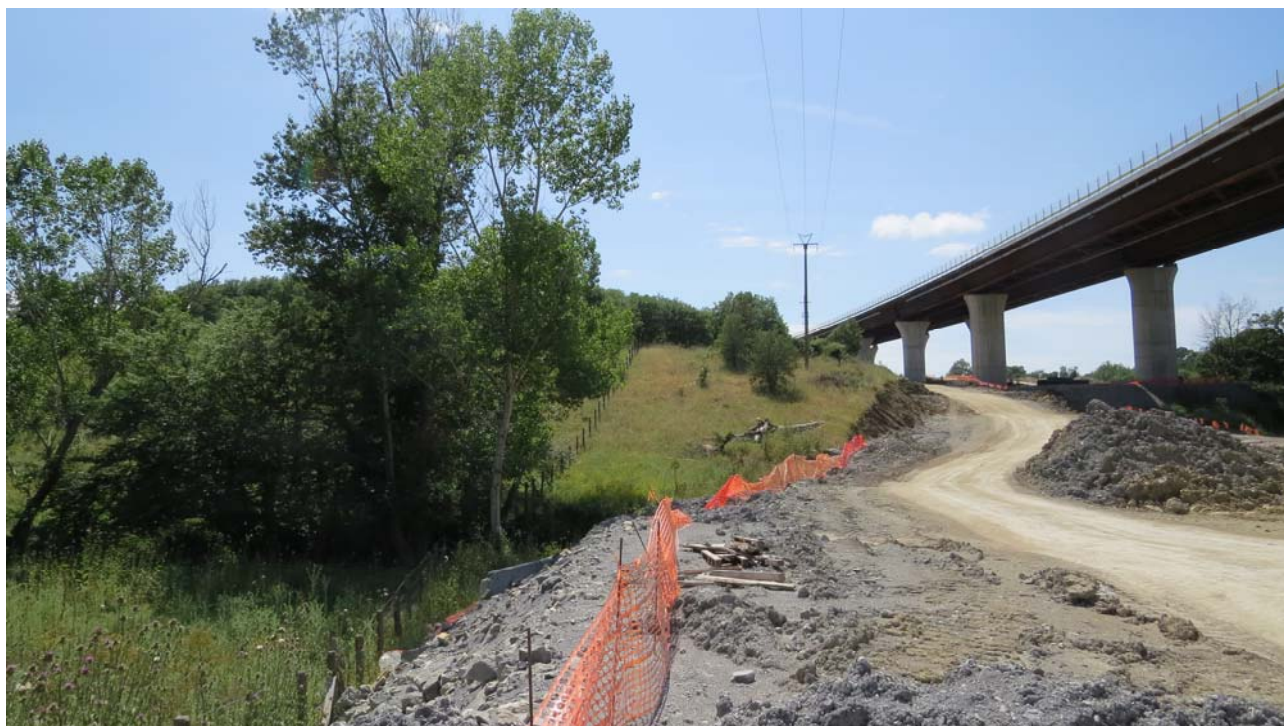
VEG 35 – Visuale zona adiacente alle attività cantieristiche
