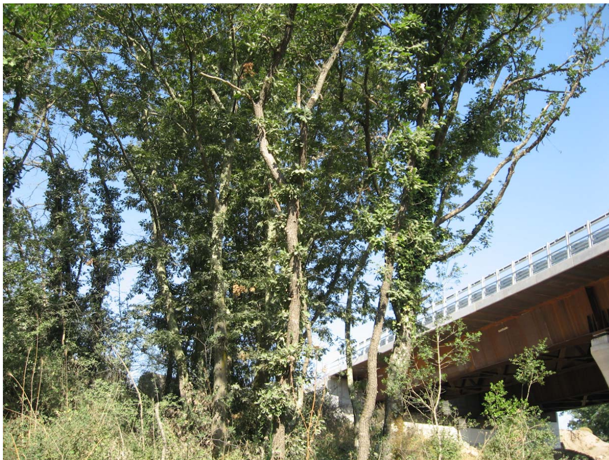
VEG 38 – Visuale sul cantiere dall'area di monitoraggio
