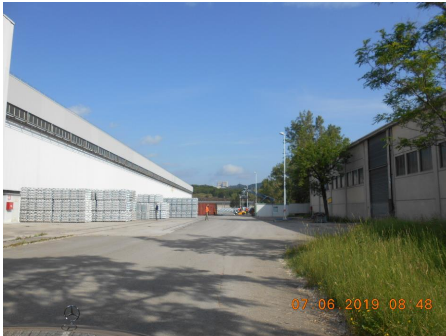
Esempio di area stivaggio esterno
