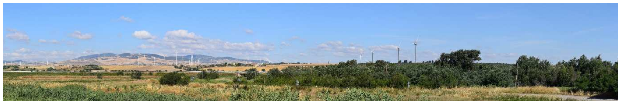
Figura 5: Panoramica dal Ponte Romano – stato post operam
