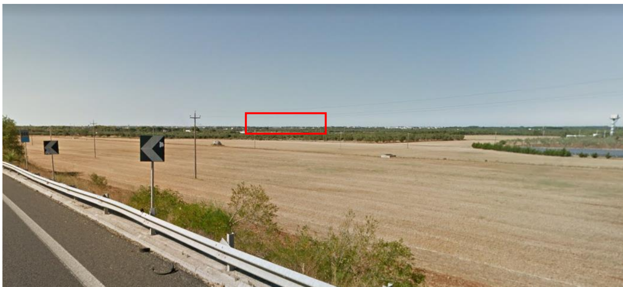
Nel riquadro in rosso il Parco eolico di Lecce3-Surbo visto ad una distanza di circa 16 km
