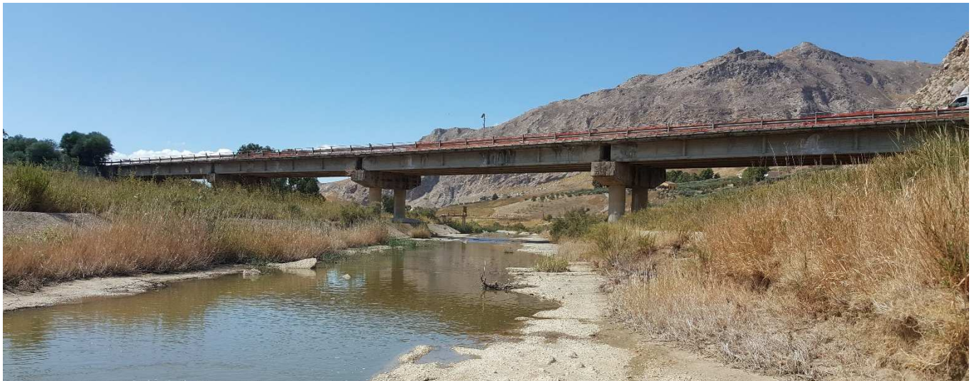
Figura 4-2: Opera esistente (vista dall'alveo attivo del Fiume Platani)
