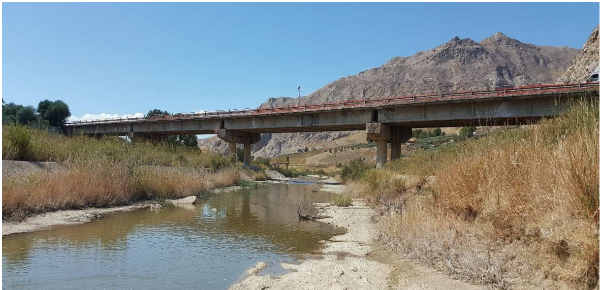
Figura 1-4 Opera esistente (vista dall'alveo attivo del Fiume Platani)
