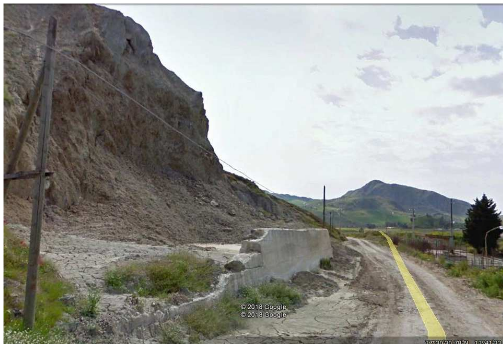
Figura 3-4 Foto percorso alternativo –interferenza, opere di sostegno e regimazione acque 2
