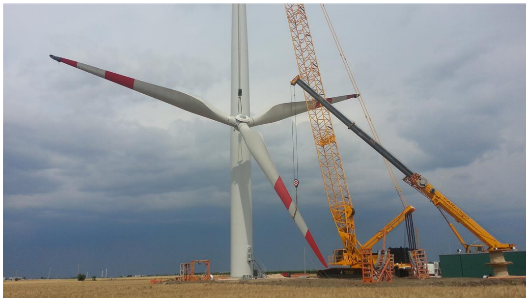
Figura 2. Smontaggio delle pale
