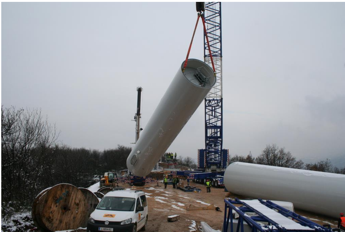
Figura 3. Smontaggio dei tronchi
