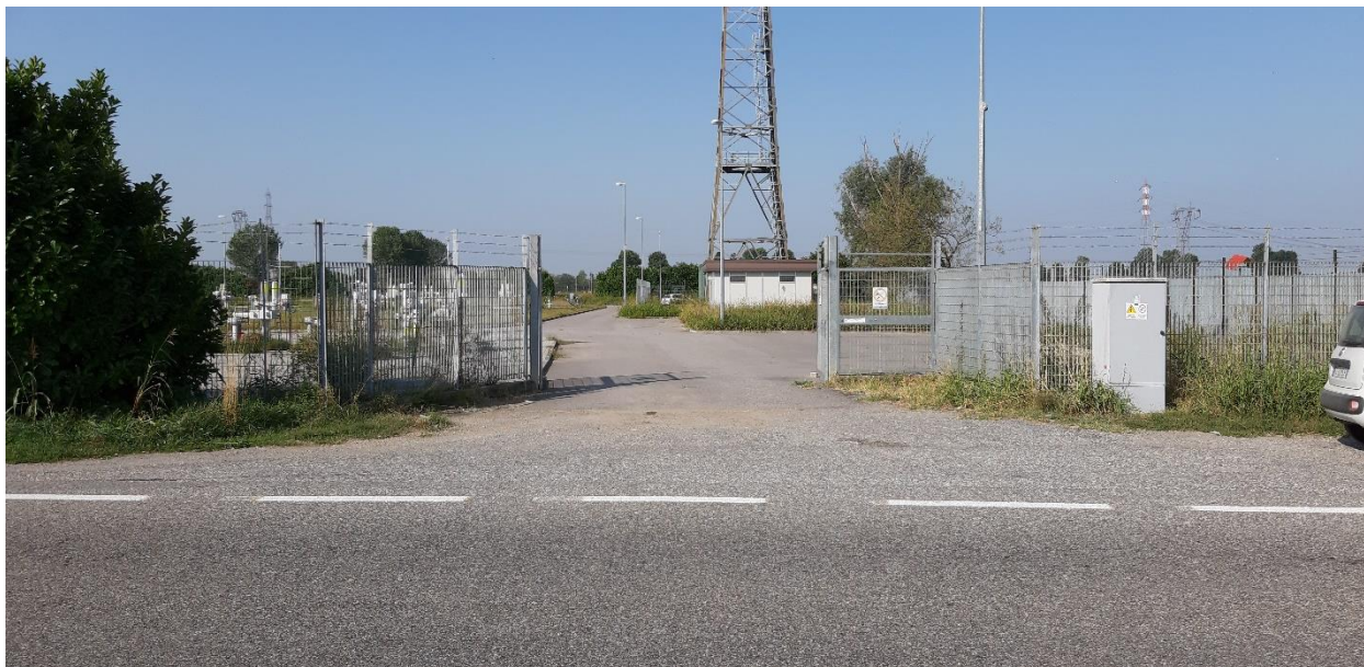
Foto n.1 – Panoramica ingresso dell’esistente area impiantistica di Cervignano d’Adda, dalla Strada Provinciale n.16d
