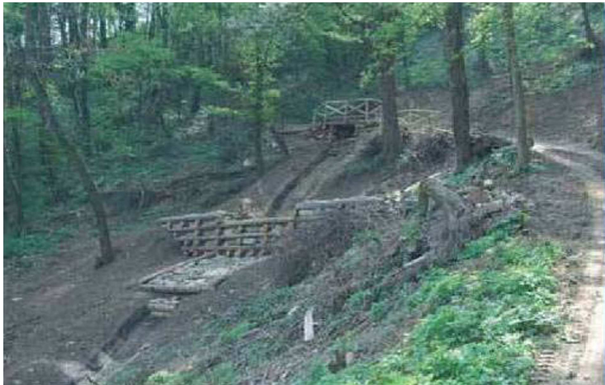
Figura 17: Esempio di briglie in legname e pietrame.
