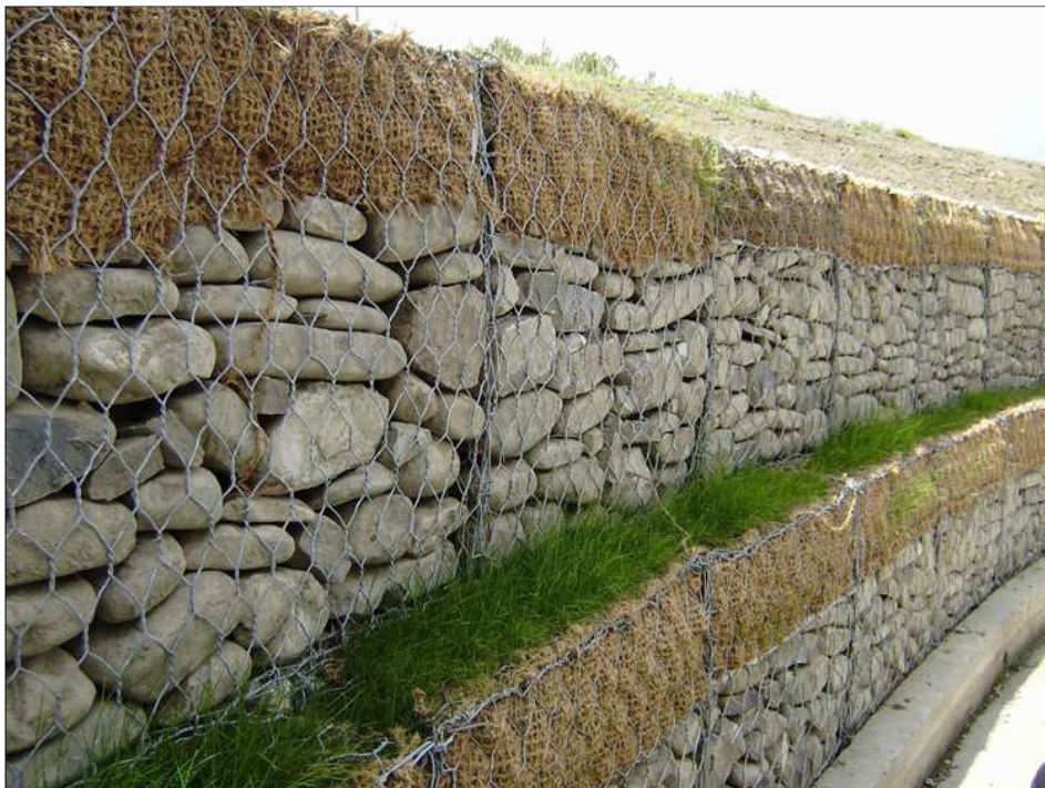
Figura 14: Esempio di opera di contenimento in gabbioni.
