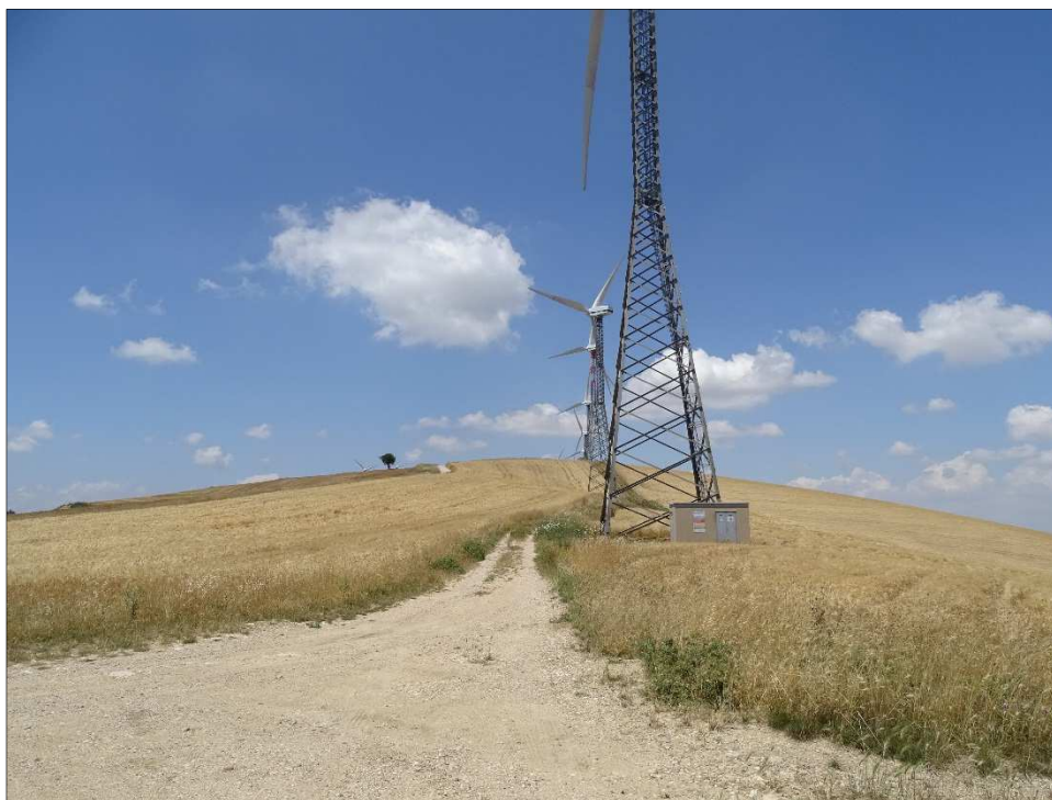
Figura 3: Vista postazione aerogeneratore esistente con la relativa cabina di macchina
