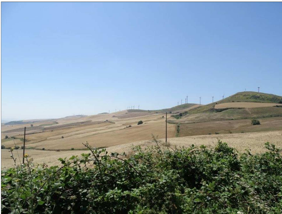
Figura 1: Vista generale del sito d'impianto
