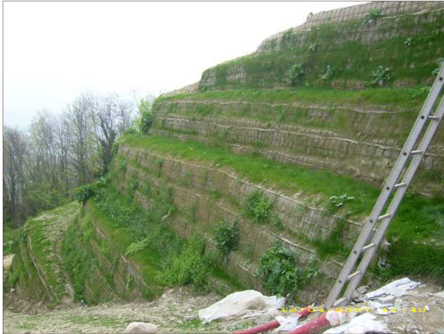
Figura 13: Esempio di rilevato in terre rinforzate.
