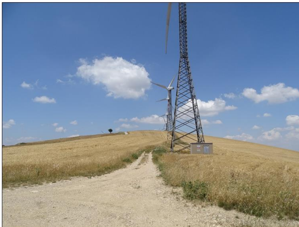
Figura 4: Vista ravvicinata impianto esistente. Al piede dell'aerogeneratore più vicino si intravede la relativa cabina di macchina
