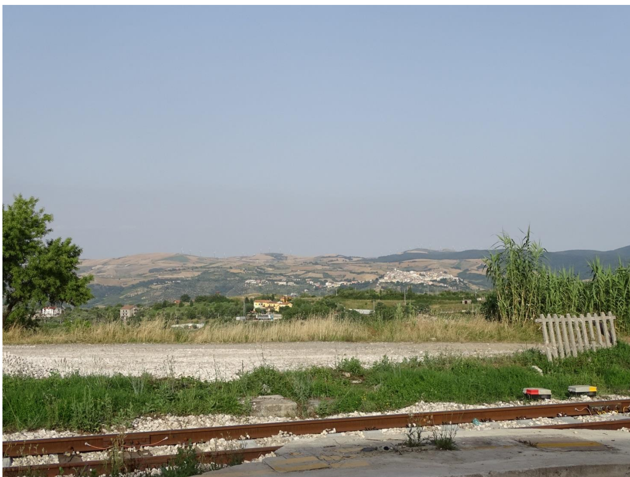
Figura 4.6-2 – Punto di vista 1 – Stato di fatto
