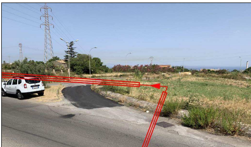
Foto 2/D – Vista senso gas dell'attraversamento della strada della Frazione G. Verga in trivellazione e trivellazione area di urbanizzazione
