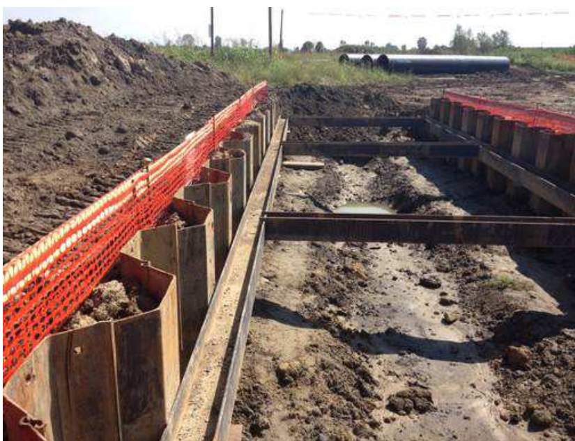
Foto 2.7/A – Scavo e palancole per attraversamento con spingitubo
