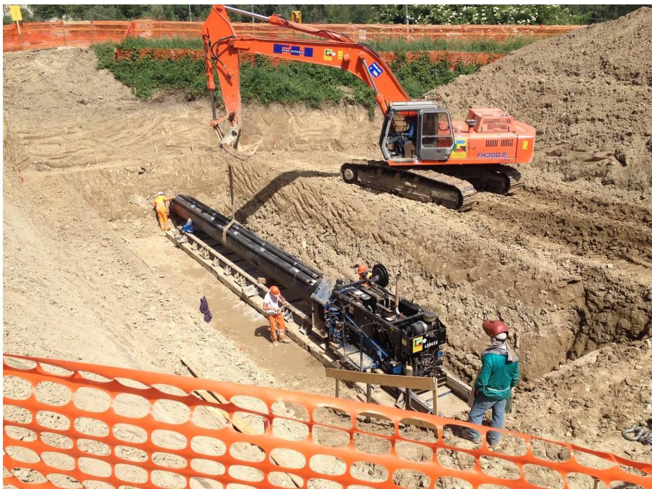
**Fig. 3-12: trivella spingitubo.**
