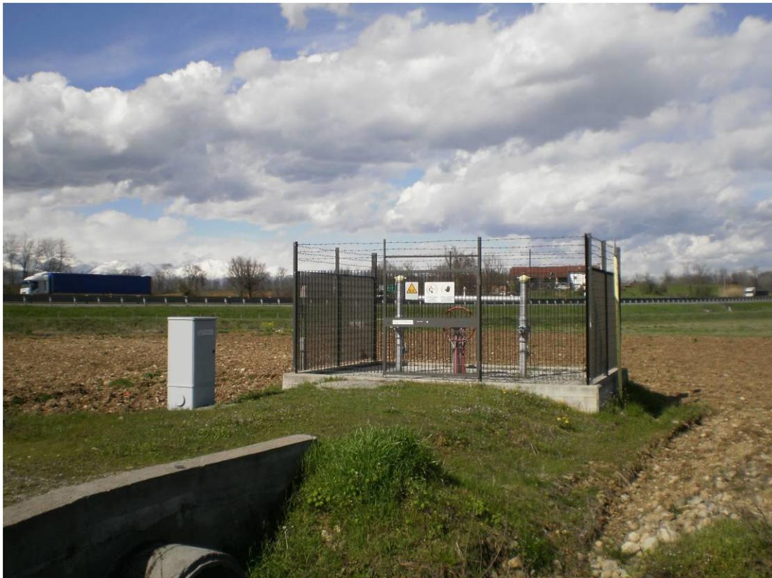
**Fig. 3-28: Esempio di impianto di intercettazione di linea (PIL).**
