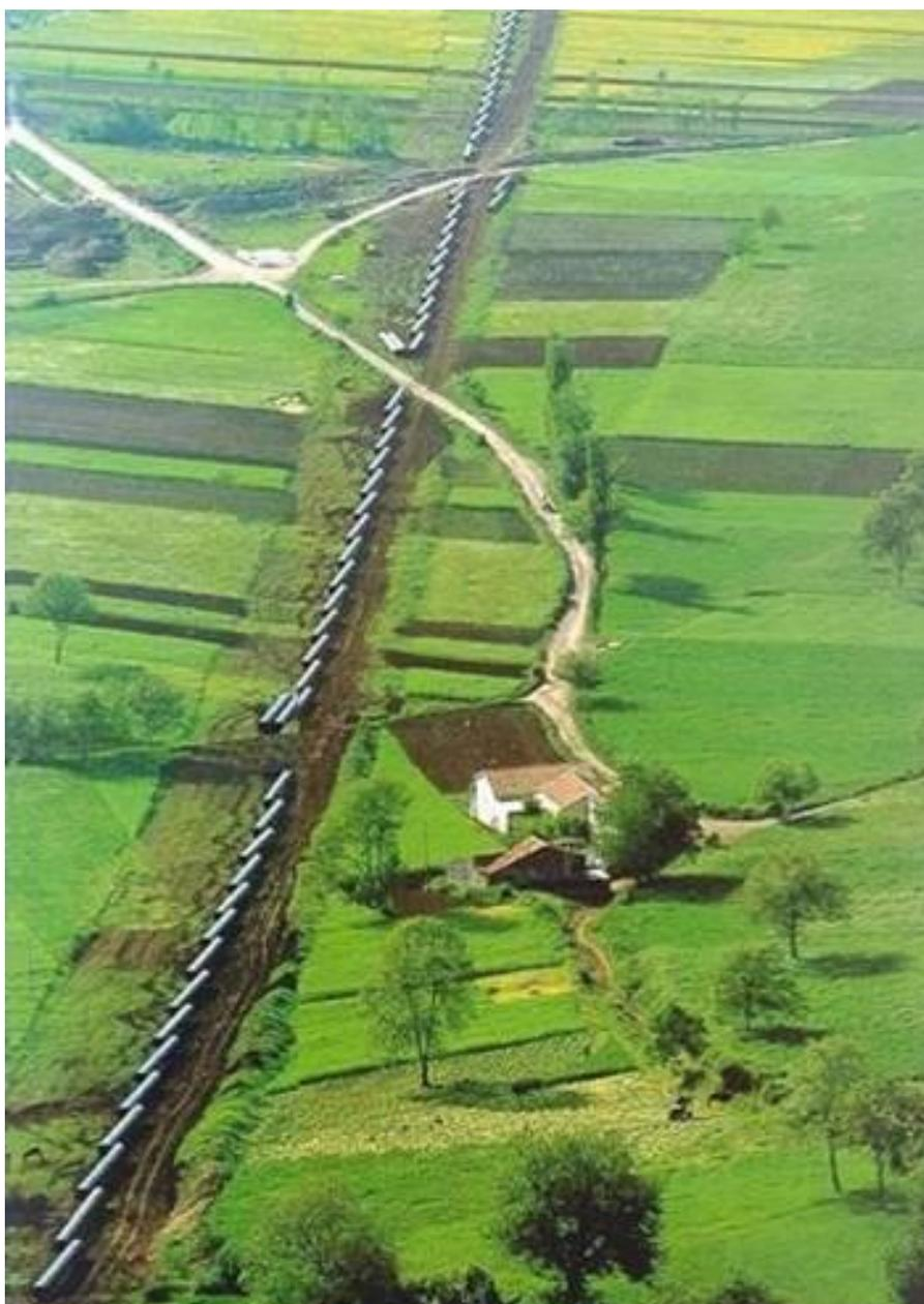
Fig. 3-5: Sfilamento dei tubi lungo la linea.
