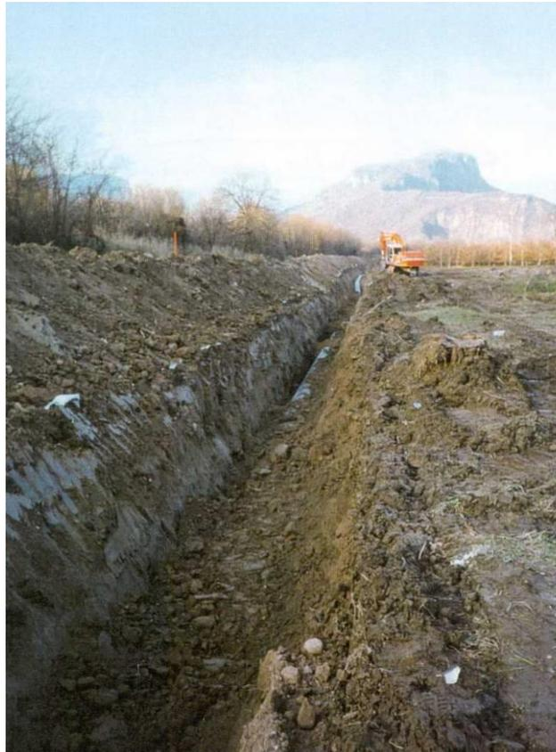
**Fig. 3-9: Operazione di rinterro della condotta.**
