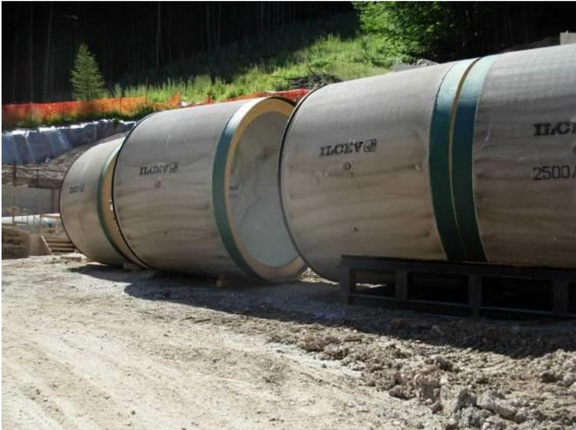
Fig. 3-18: Stoccaggio tubi in c.a.
