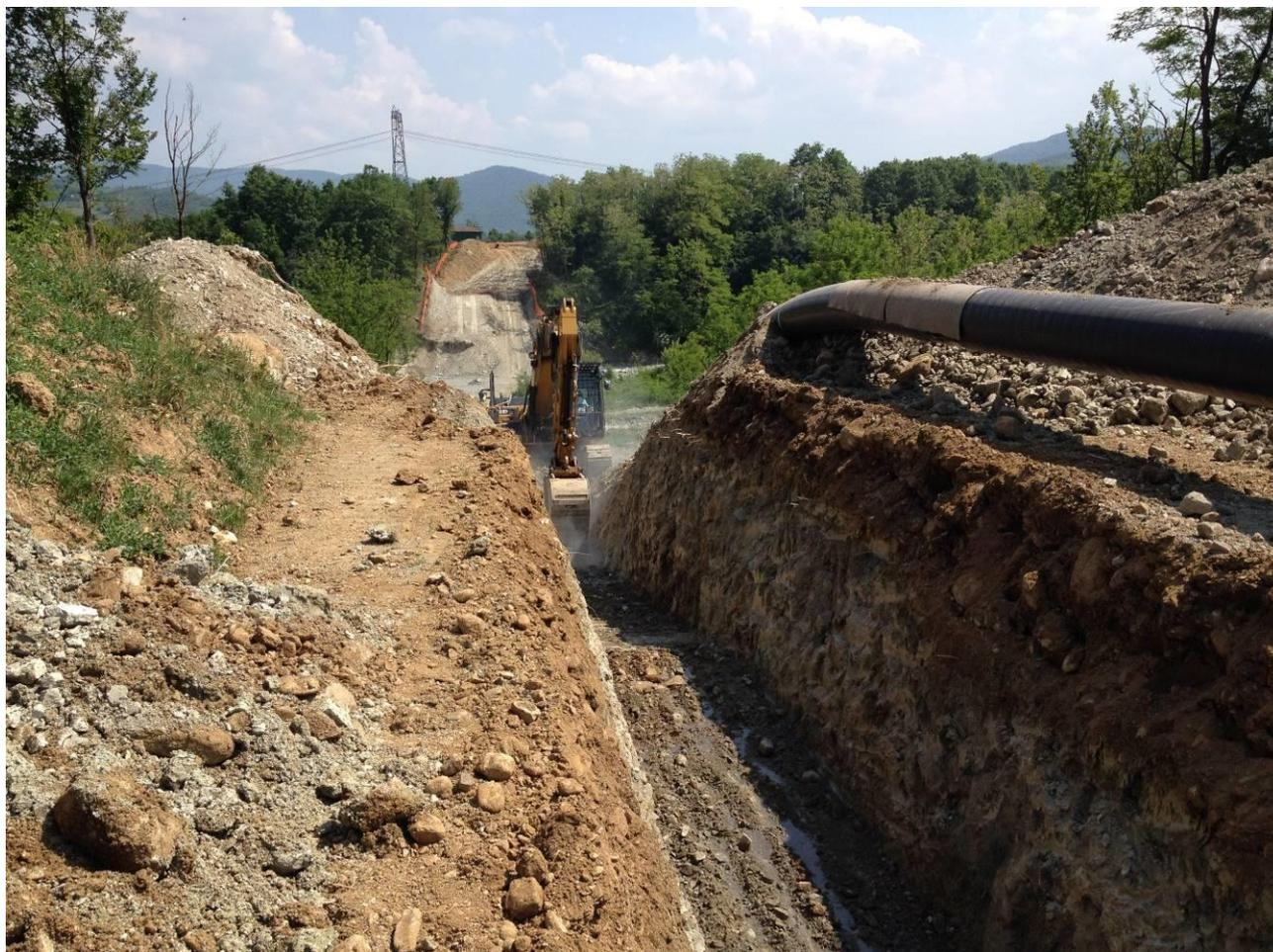
**Fig. 3-7: Scavo per l'alloggiamento della condotta.**
