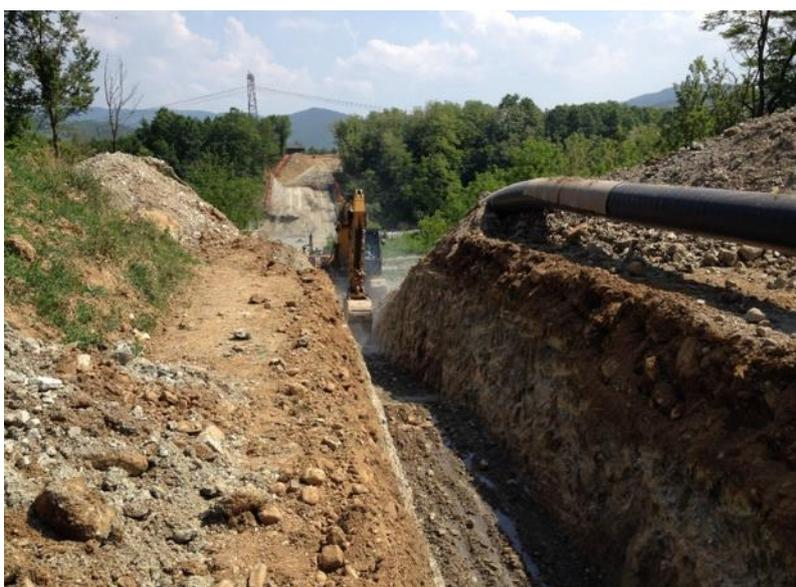
**Figura 1.2 – Scavo per l'alloggiamento della condotta.**
