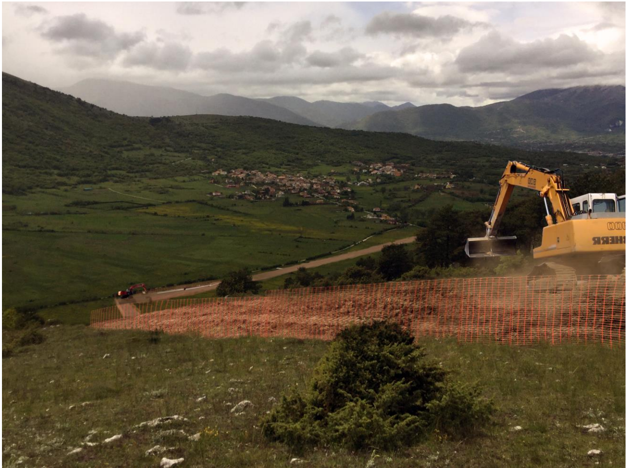
Fig. 5.5 - Apertura dell'area di passaggio.
