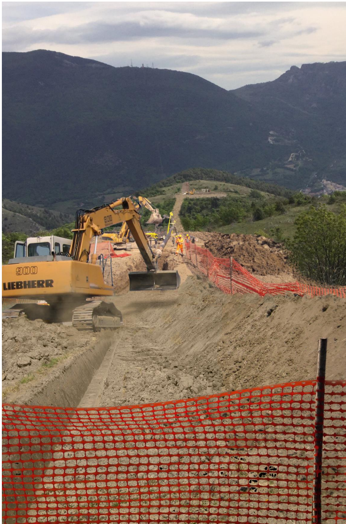
Fig. 5.2 - Apertura dell'area di passaggio.
