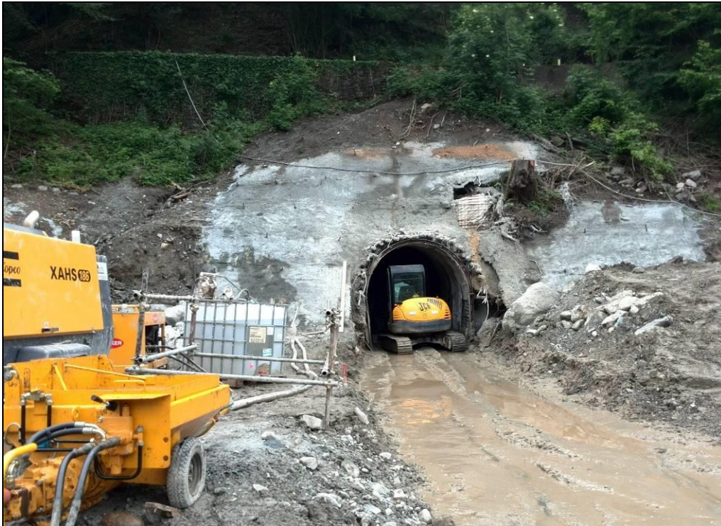
Fig. 6-28 - Galleria di base.
