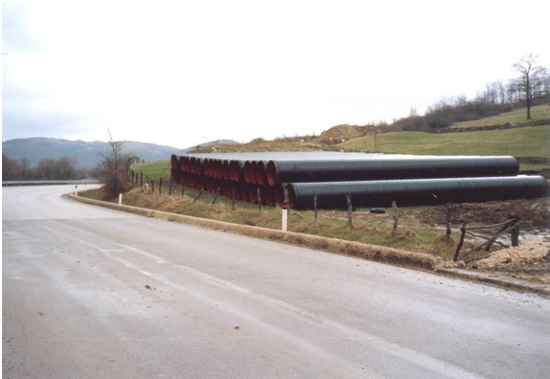
Fig. 6-7 - Piazzole di accatastamento tubazioni.
