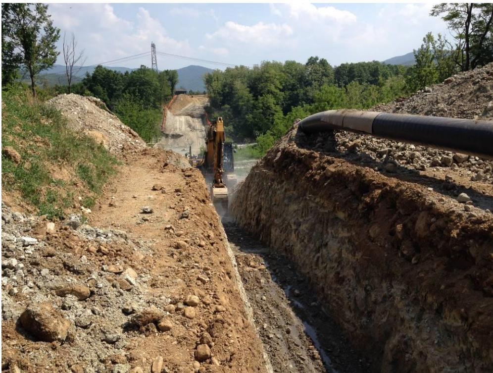
Fig. 6-10- Scavo per l'alloggiamento della condotta.
