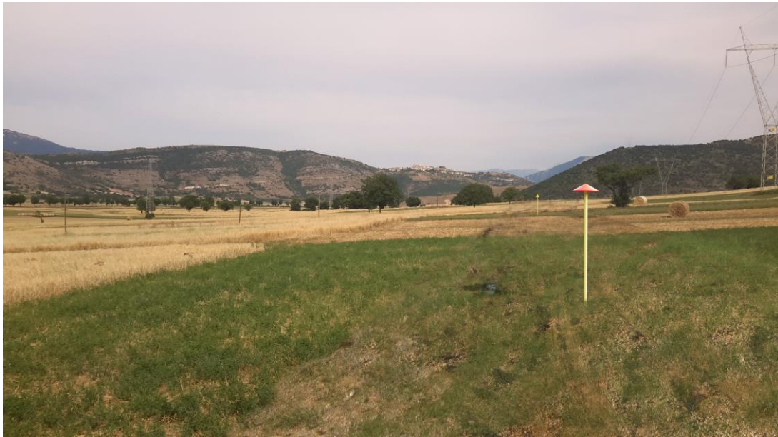
Fig. 5.9 - Percorrenza della Piana di Navelli a ripristini terminati
