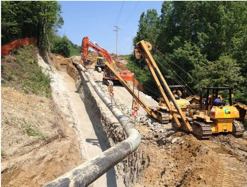
Fig. 6-11- Sollevamento e posa della colonna.
