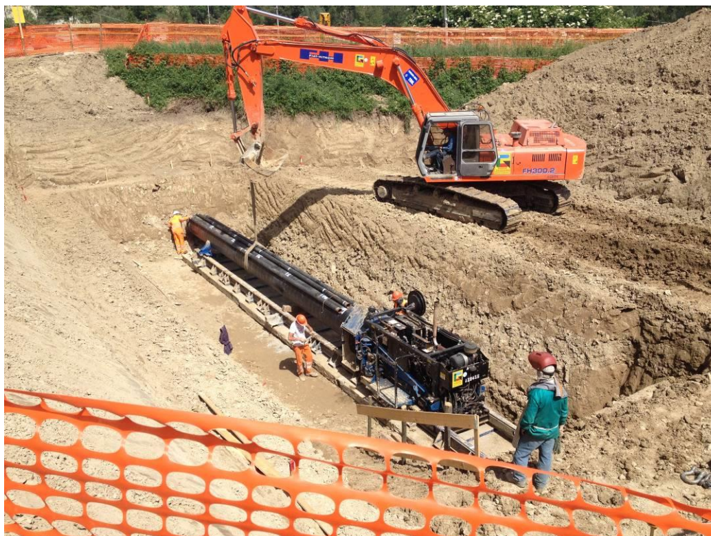
Fig. 6-17: trivella spingitubo.
