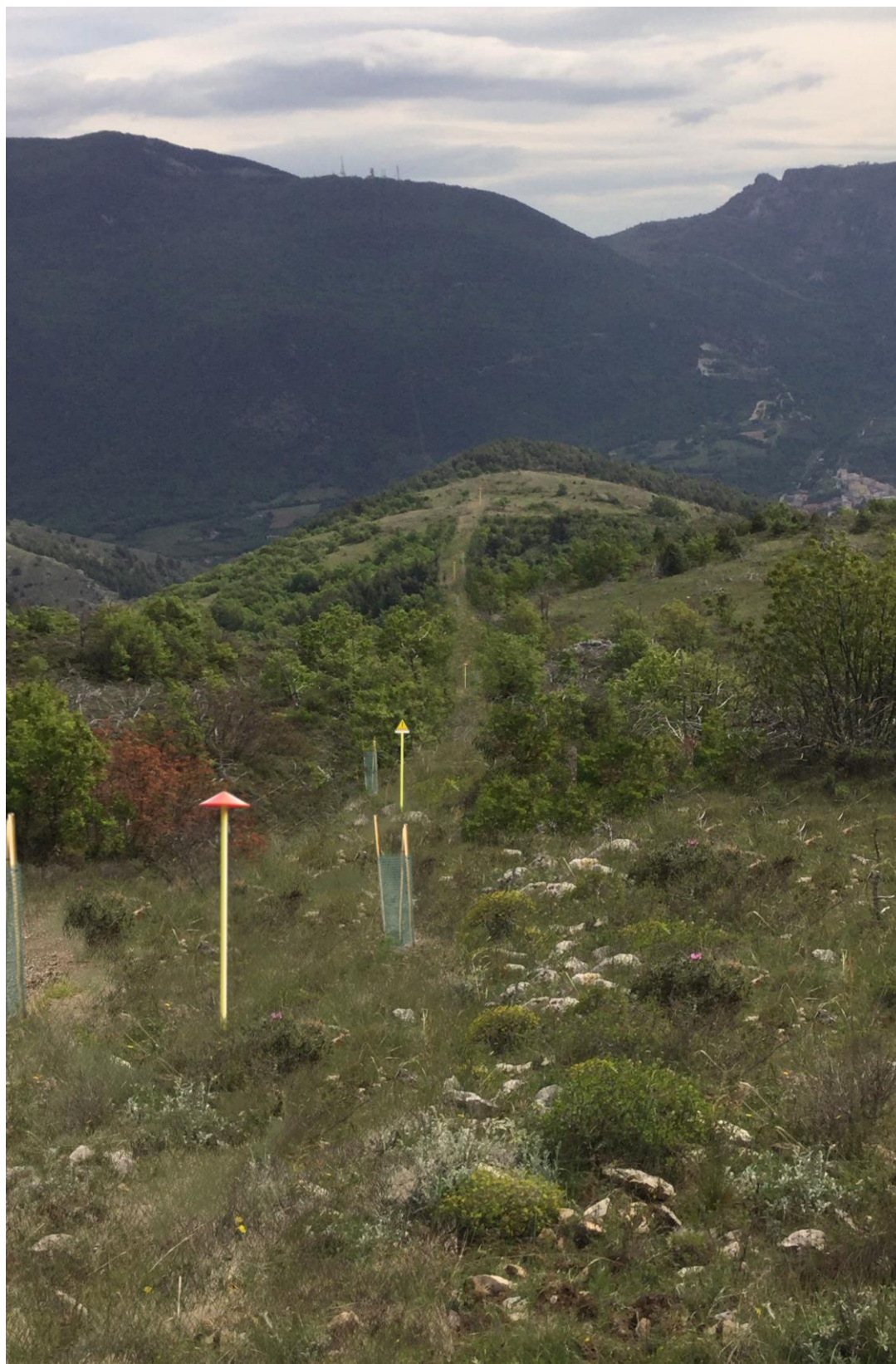
Fig. 5.3 - Termine dei lavori. Ripristini morfologici ed inerbimento eseguiti. Rimangono fuori terra solo i cartelli segnalatori.
