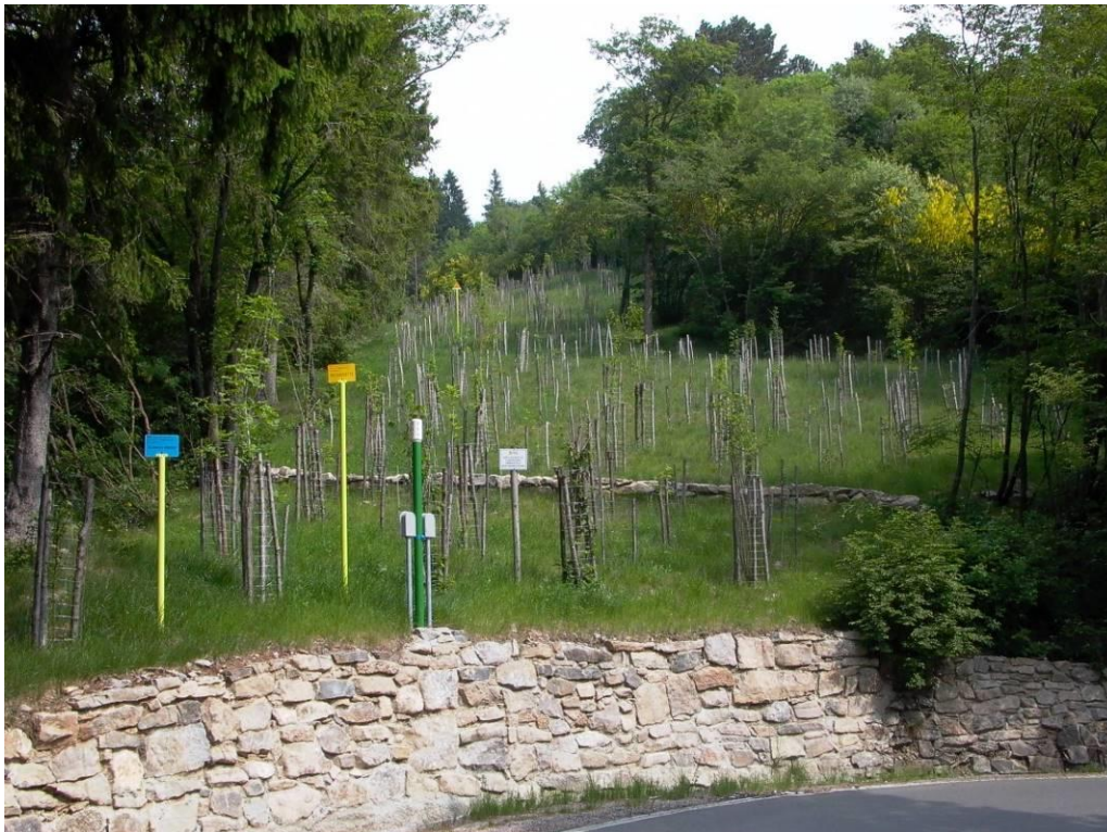
Fig. 6.40 - Ripristino vegetazionale con piantagione diffusa e protezioni individuali. Tubi di sfiato posto in corrispondenza di attraversamento eseguito con tubo di protezione.
