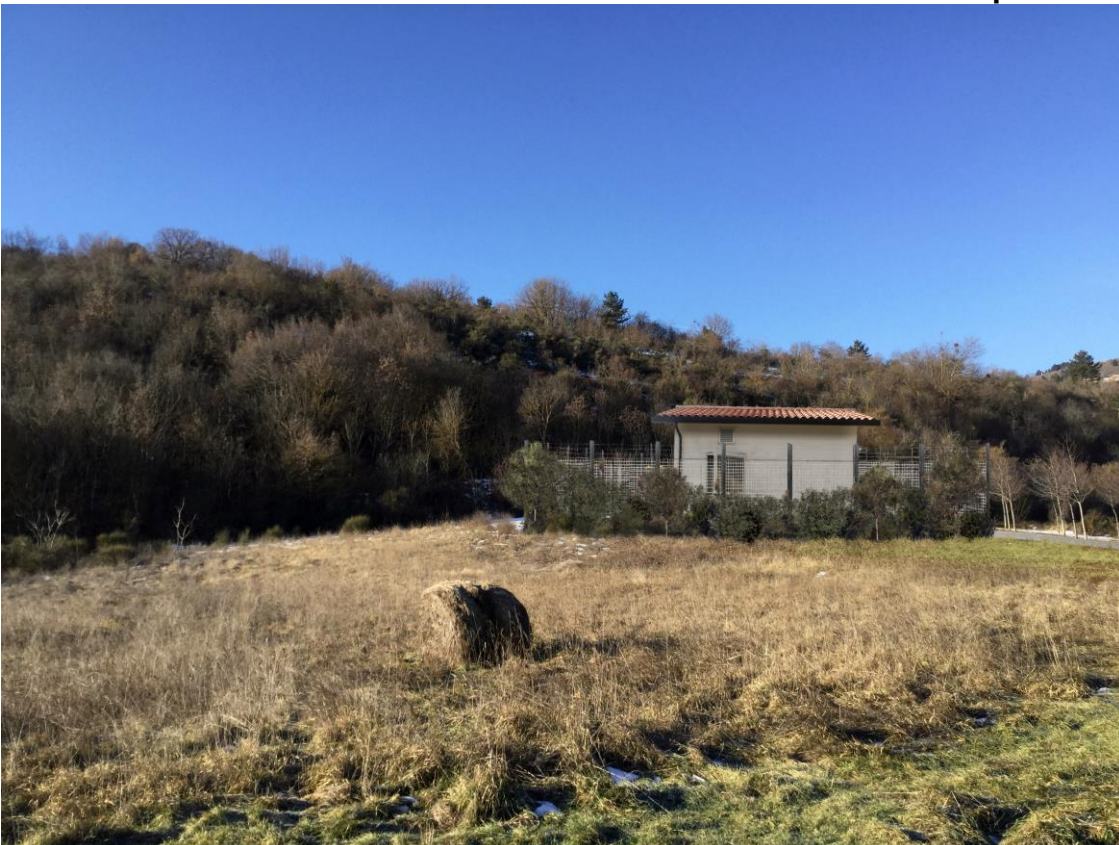
Fig. 5.11 - PIDI n.45430/18 in comune de L'Aquila a mascheramento effettuato
