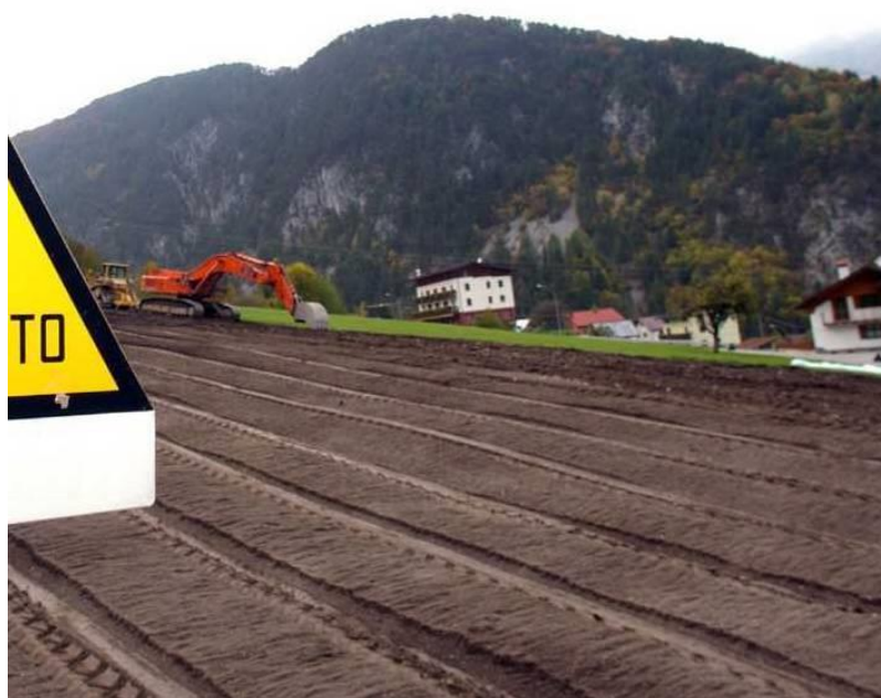
Fig. 6-13- Ridistribuzione dello strato humico superficiale.
