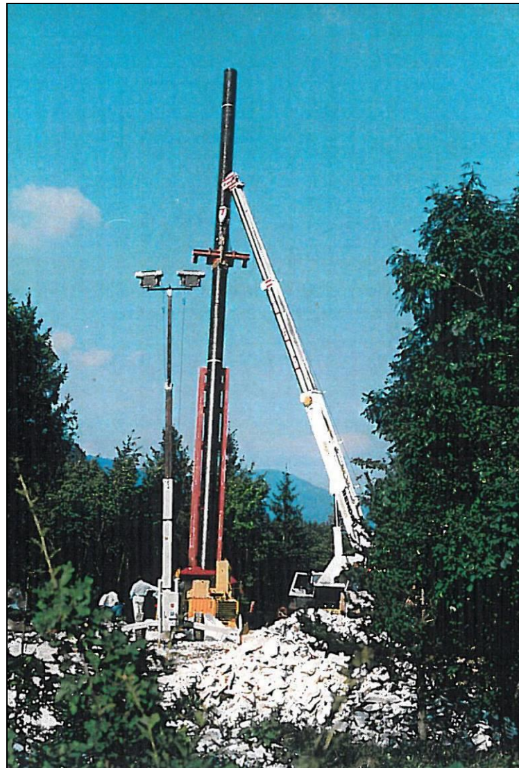
Fig. 6-31 - Varo della condotta.
