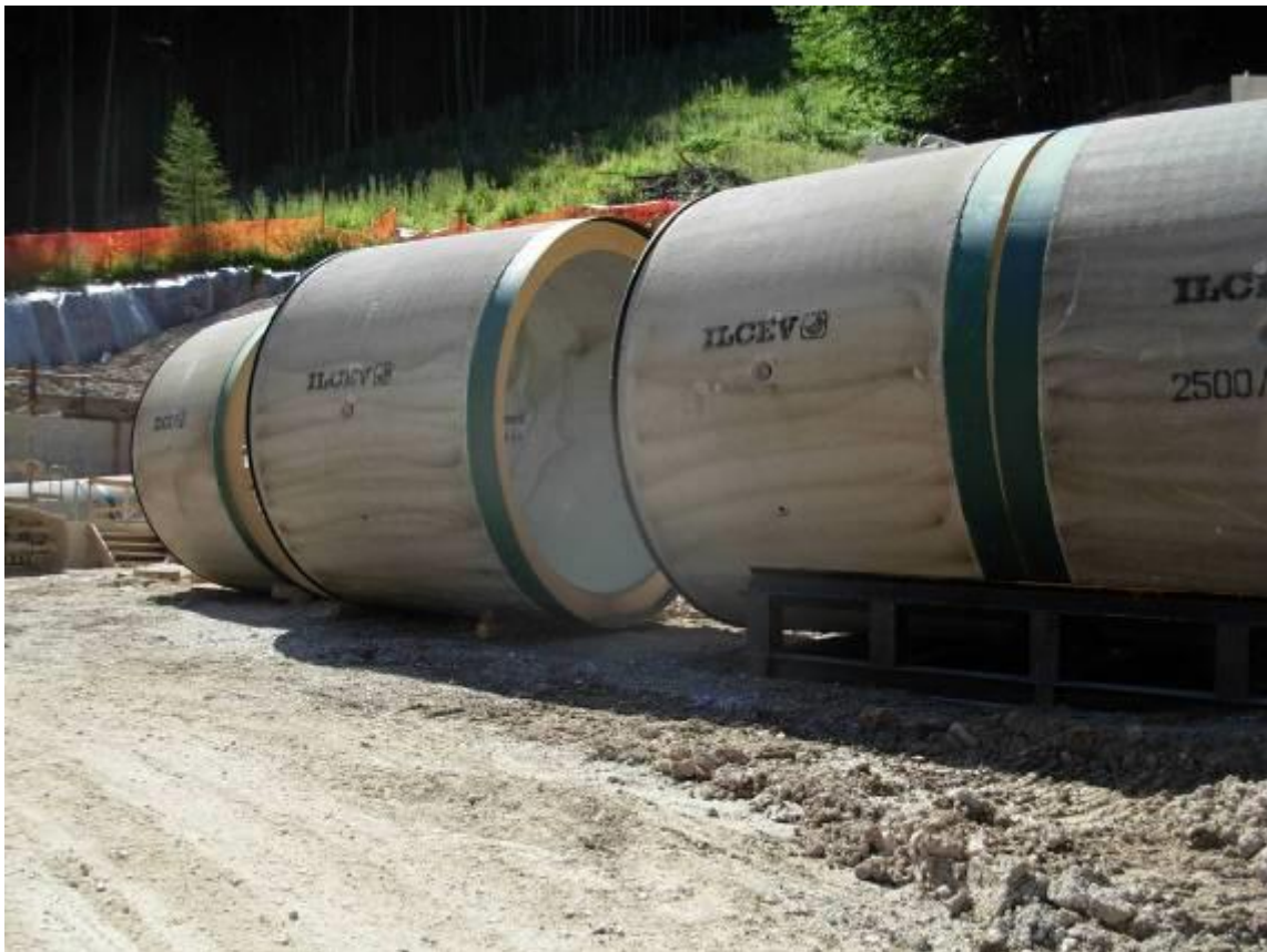
Fig. 6-24 - Stoccaggio tubi in c.a.
