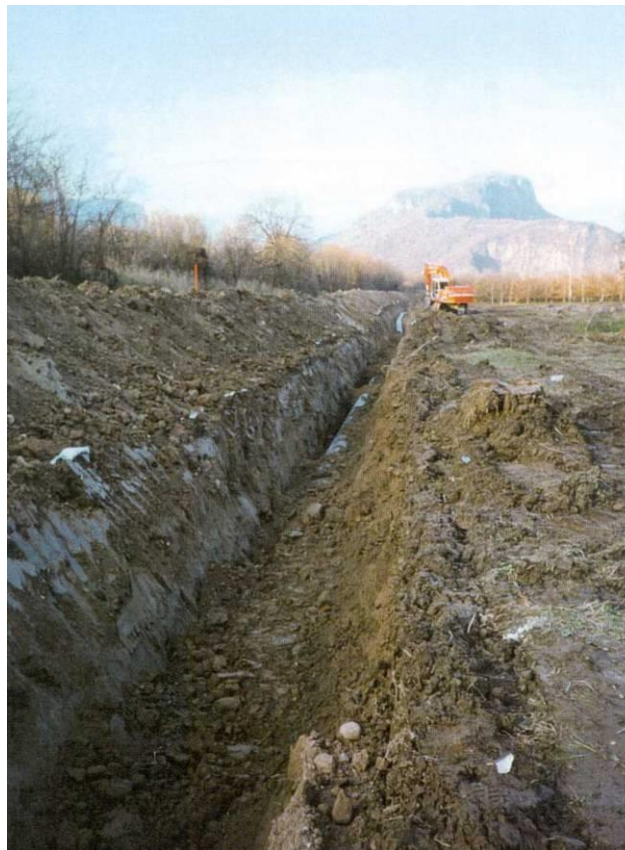
Fig. 6-12- Operazione di rinterro della condotta.
