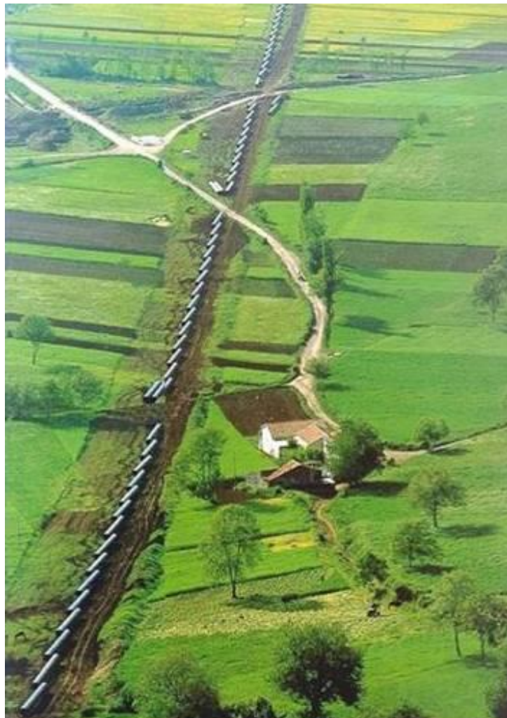
Fig. 6-8- Sfilamento dei tubi lungo la linea.
