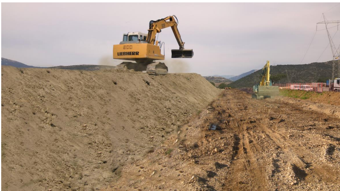
Fig. 5.8 - Apertura dell'area di passaggio
