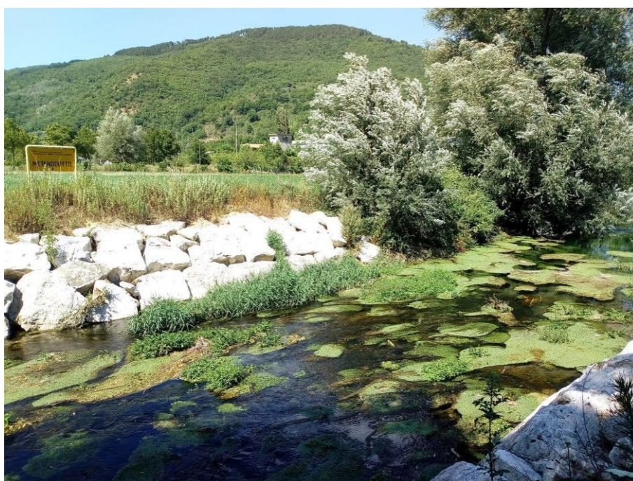
Figura 4-10: Fiume Velino attraversato dai lavori del 2017 con ripristino spondale in massicciata semplice al KP di progetto 125+600 circa. La
