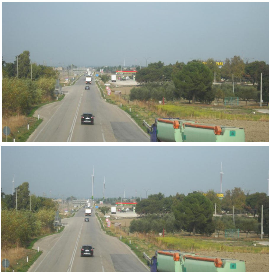
Figura 2: Vista da SUD ante operam e post operam (S.S. 16)
